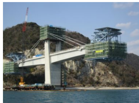
写真-3 超大型移動作業車による張出施工
