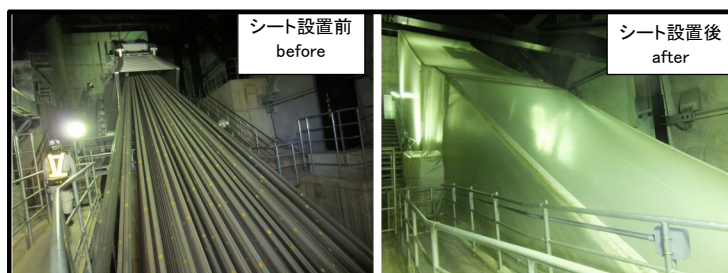
写真-1 サドル部付近の防湿シート設置状況
