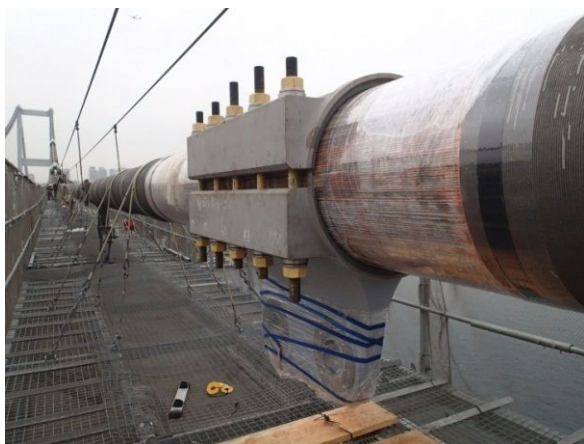
写真-4 第一ボスポラス橋 ケーブルバンド取替え Photo 4 Bosphorus Bridge, Replacement work of Cable Band
