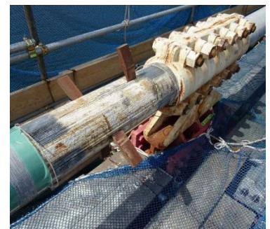
写真-5 主ケーブル開放状況 Photo. 5 Internal inspection work for main cable
