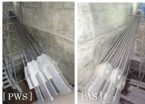
写真-4 主ケーブルアンカー Photo. 4 Anchoring part of main cable
