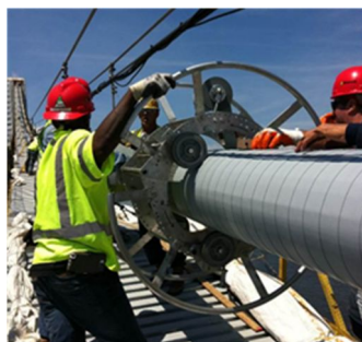
写真-4 ゴムラッピング Photo.4 Elastomeric Wrapping
