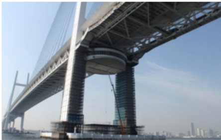
写真-1 枠組足場
