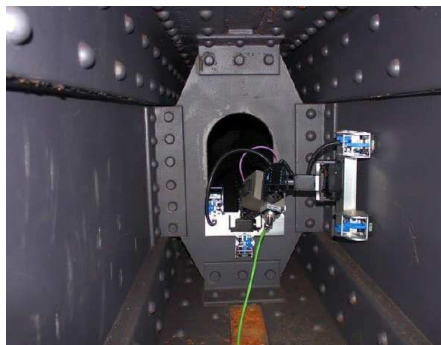
写真-8 実橋での点検状況 Photo 8 Inspection on site
