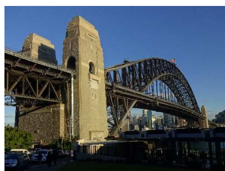
写真-9 シドニーハーバーブリッジ Photo 9 Sydney Harbour Bridge
