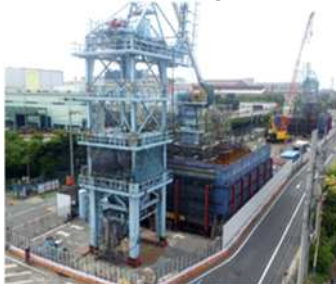
写真-3 現場全景
