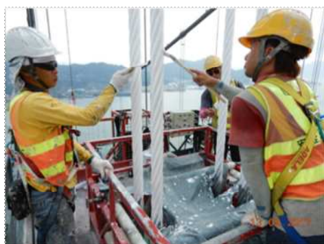
写真-12 ハンガーロープの塗替え状況 Photo 12 Painting to Suspenders
