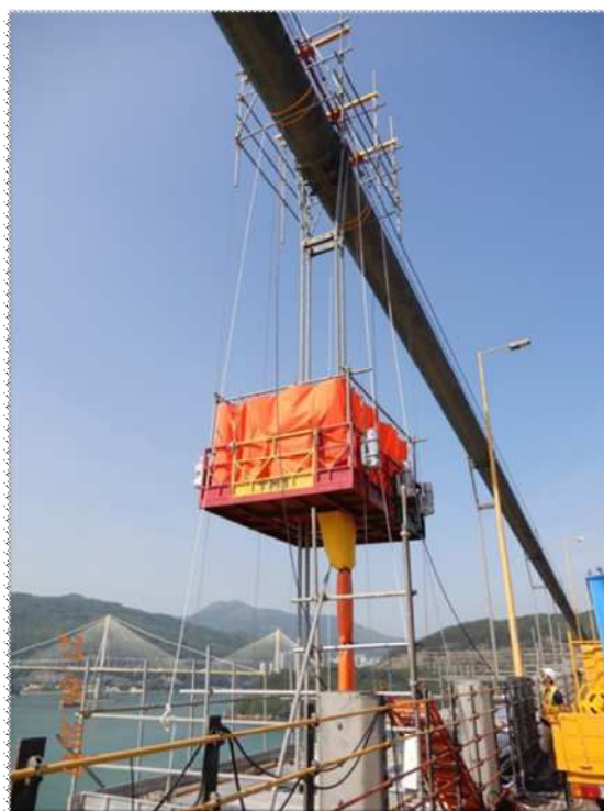
写真-11 ウォータージェット洗浄 Photo 11 Water Jet Cleaning
