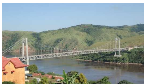
写真-5 マタディ橋全景 Photo 5 Matadi Bridge
