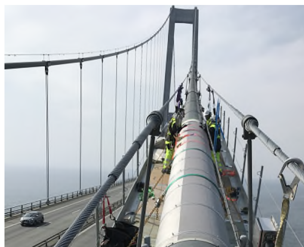
写真-5 防火対策の設置（2019年） Photo 5 Fire protection work in 2019
