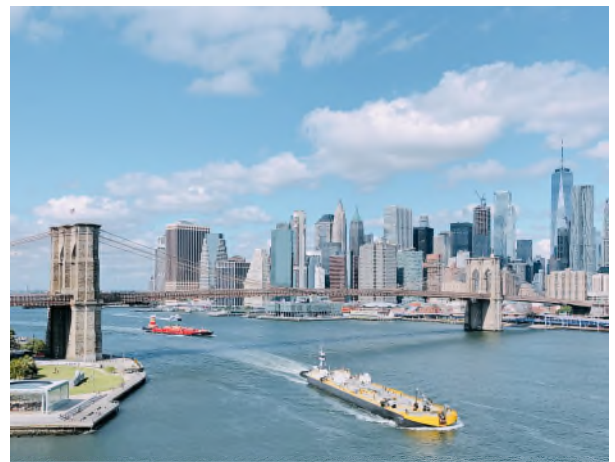
写真-7 マンハッタン橋よりブルックリン橋を望む
