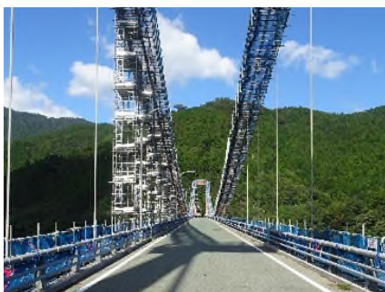
写真-7 工事用足場
