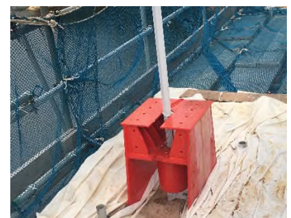
写真-9 ハンガーロープの補修
