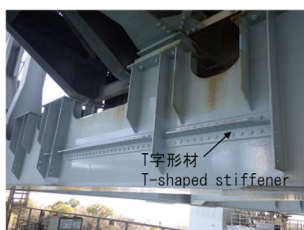
写真-3 T字形材の設置状況 Photo-3 Installed T-shaped stiffener
