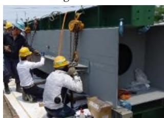
写真-4 施工性試験 Photo-4 Construction test
