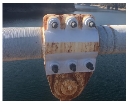
写真-8 ケーブルバンドボルトの取替え
