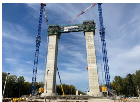
写真-8 スリップフォームによる主塔施工
