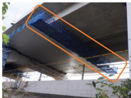
写真-3 スライド式下面防護工設置状況 Photo-3 Fall-prevention unit
