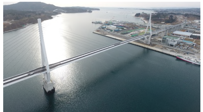
写真-5 気仙沼湾横断橋全景
