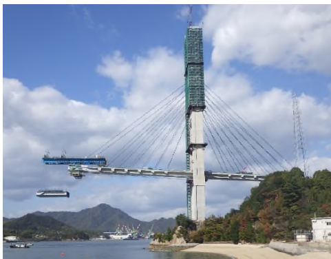
写真-6 鋼桁架設の様子 Photo-6 Steel girder erection
