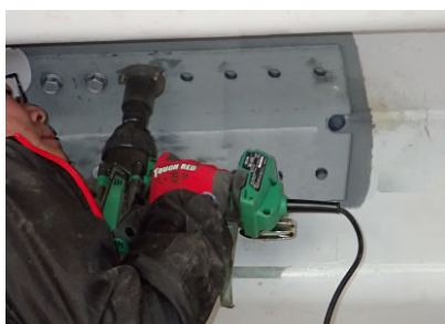
写真-3 TRS 締め込み（デッキ側） Photo-3 TRS tightening
