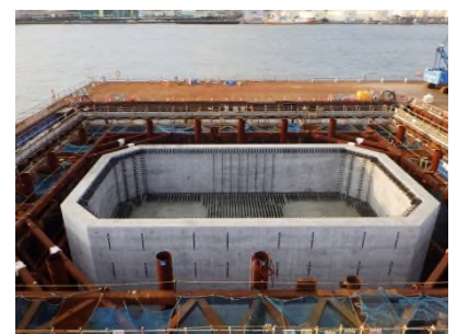
写真-7 橋脚躯体完成 Photo-7 Tower base completion
