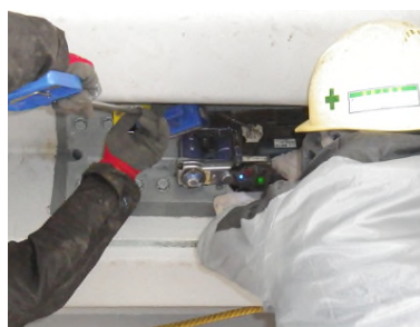
写真-2 ボルト孔の削孔（デッキ側） Photo-2 Perforation of bolt hole
