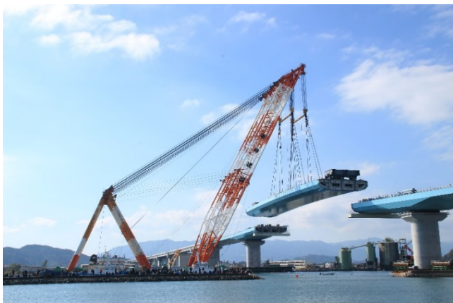
写真-3 中央大ブロック架設状況 Photo-3 Erection of central large girder segment
