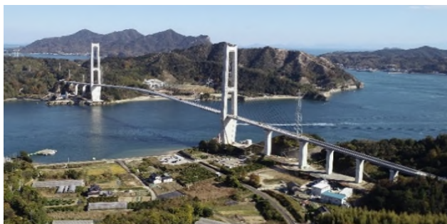
写真-1 岩城橋の状況 (令和 3 年 12 月現在) Photo-1 Iwagi Bridge (December, 2021)
