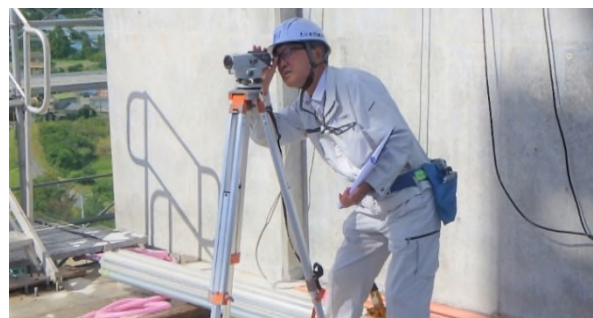
写真-2 橋脚の出来形を確認する JB 本四高速の担当技術者 (令和元年 10 月)
