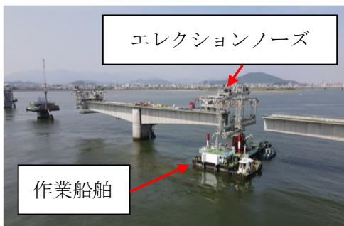
写真-3 エレクションノーズ架設状況 Photo-3 Construction of erection nose
