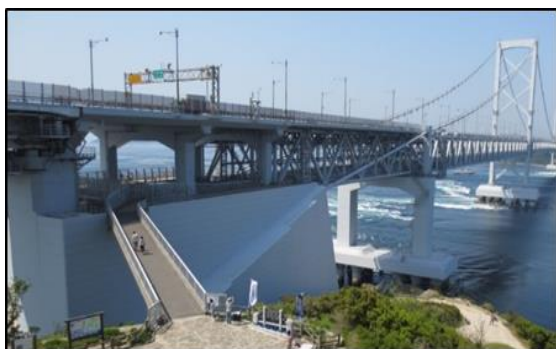
写真-1 大鳴門橋 1A 上屋道路桁 Photo-1 Girder at an anchorage of Ohnaruto Bridge
