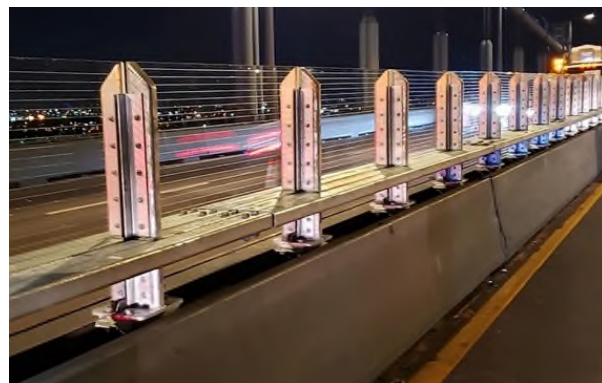
写真-2 中央防護壁のかさ上げ Photo 2 Median Barrier Extension
