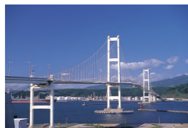
写真-3 白鳥大橋
