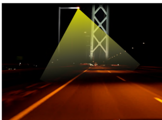
写真-1 ポール照明方式 Photo 1 Pole lighting method
