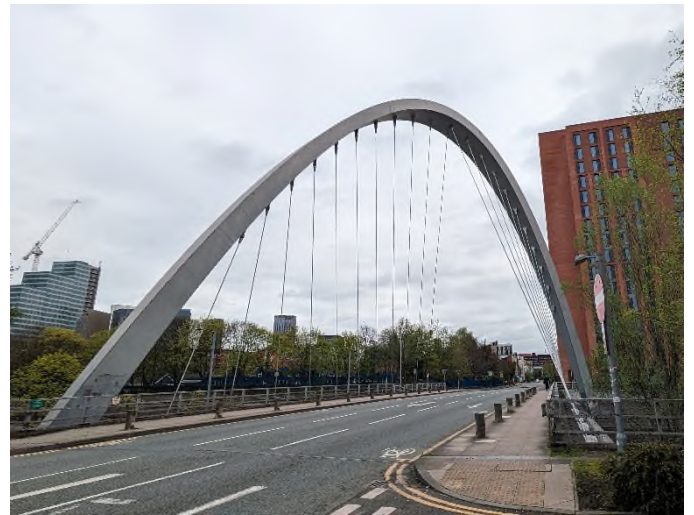
写真-8 ヒュームアーチ橋他市内橋梁視察 Photo 8 Hulme Arch Bridge on a field trip
