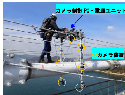
写真-2 大島大橋中央 傾斜角 8° 未満
