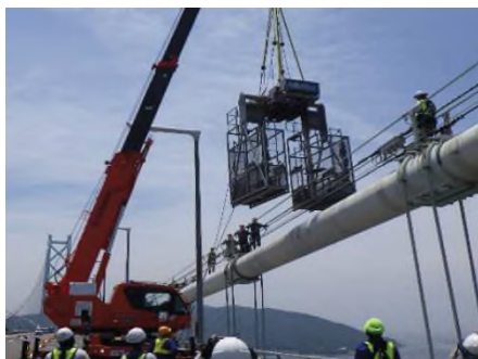
写真-1 ケーブル作業車架設状況
