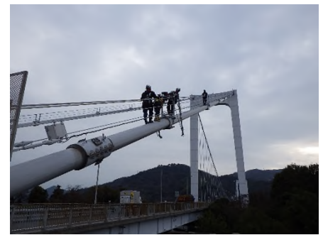
写真-3 大島大橋側径間 傾斜角 24°
