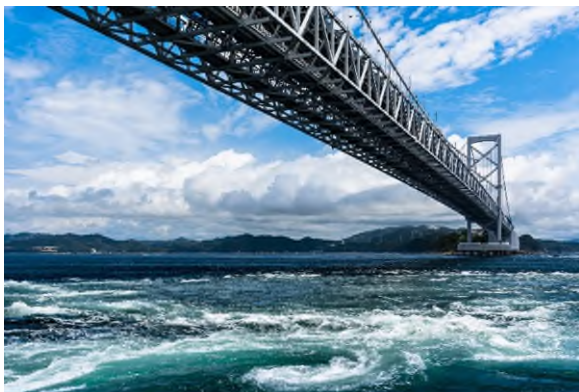
写真-1 大鳴門橋 Photo 1 Ohnaruto Bridge
