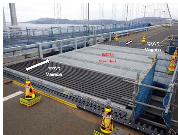
写真-2 モジュラー型伸縮装置設置状況
