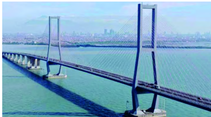
写真-4 スラマドゥ橋
