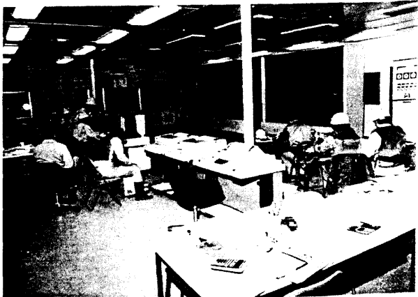
写真-6 MP船中央制御室
