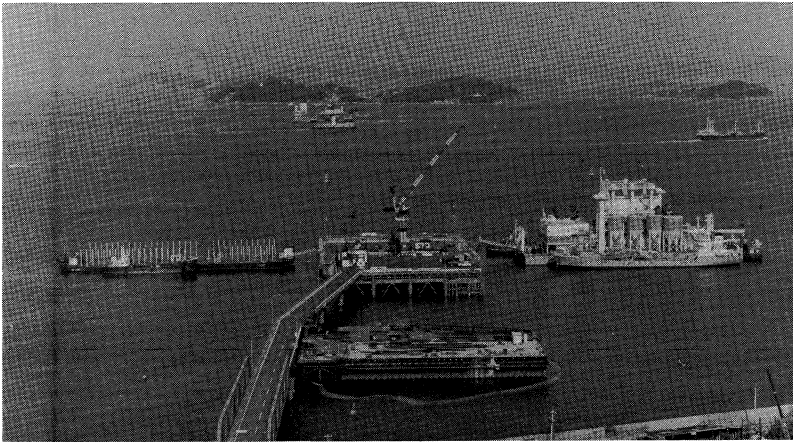
南北備讃瀬戸大橋7Aモルタル注入 (第1回目) 状況 (57年11月)
