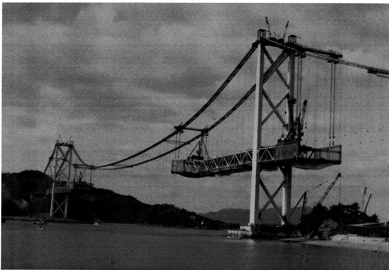
因島大橋補剛桁架設
