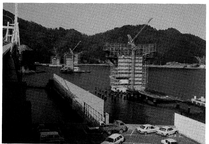
撫養橋下部工工事
