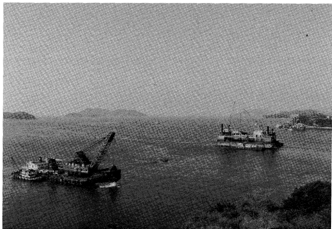
岩黒島橋下部工（その１）工事
