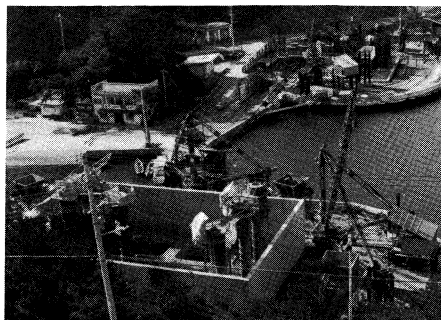
写真-3 ケーソン構築状況
