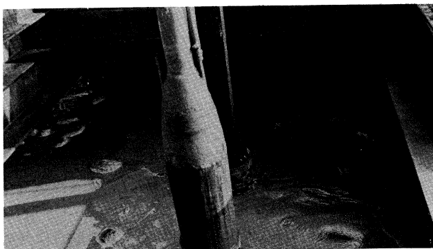
写真-5 注入管パッカー
