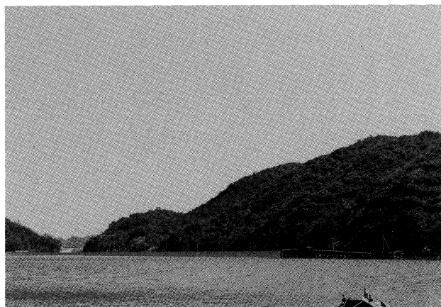
内ノ海地区準備工事 (58年 8月)
