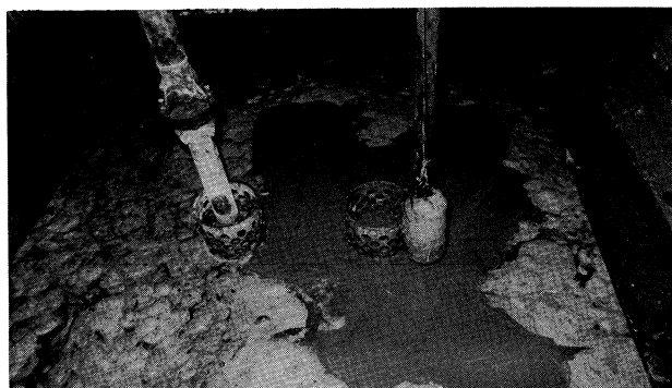
写真-6 注入管と検知管
