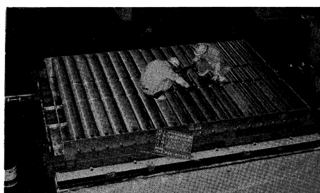
写真-12 下沓(下底板、ローラ組立)
