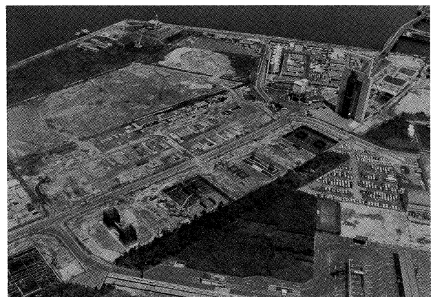
番ノ州高架橋下部工工中（その２）躯体工事（58年7月） （4P：フーチング養生）（5P：3リフト鉄筋組） （6P：なし）（7P：ジャンプフォーム足場組立）
