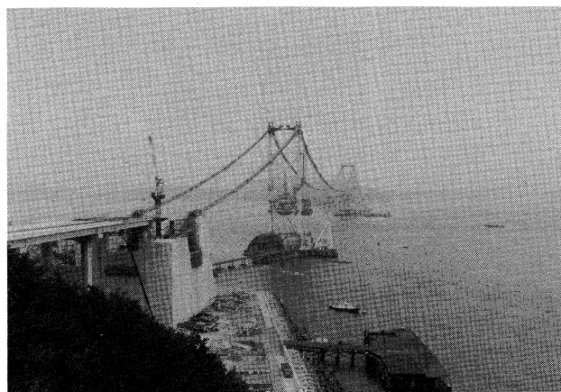
大鳴門橋補剛桁架設工事 (58年 8月)
