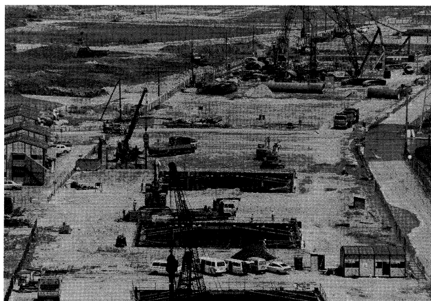
番ノ州高架橋下部工（その3）工事 （6P、7P：場所打ぐい完了） （8P、9P：構造物掘削） （58年7月）
