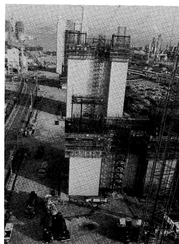
番ノ州高架橋下部工(その2)躯体工事
