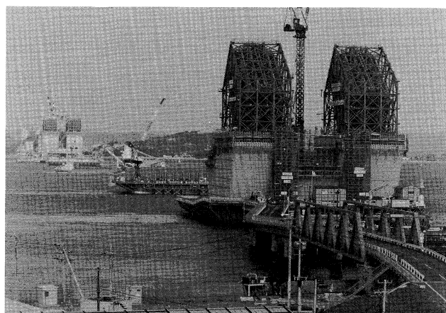
南北備讃瀬戸大橋下部工南工区(その4)工事 (58年11月)
