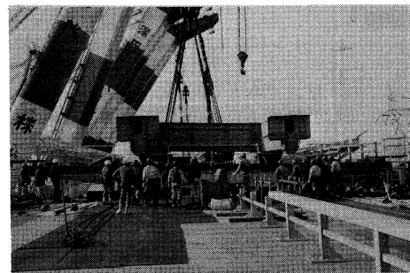
写真-8 G5桁架設用セッティングビーム (セッティングビームはG6桁架設に転用)
