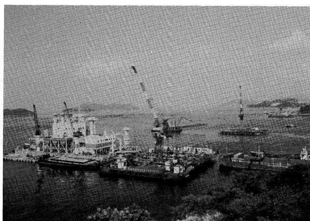
岩黒橋下部工(その1)工事
