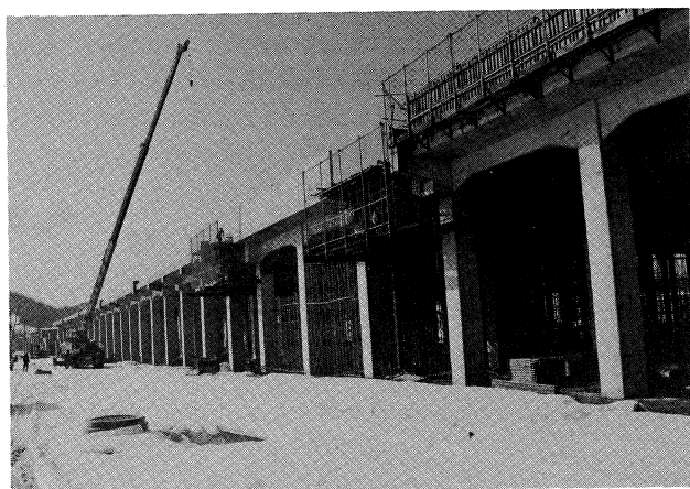
本四備讃線児島高架橋(その1)工事 (59年2月)
