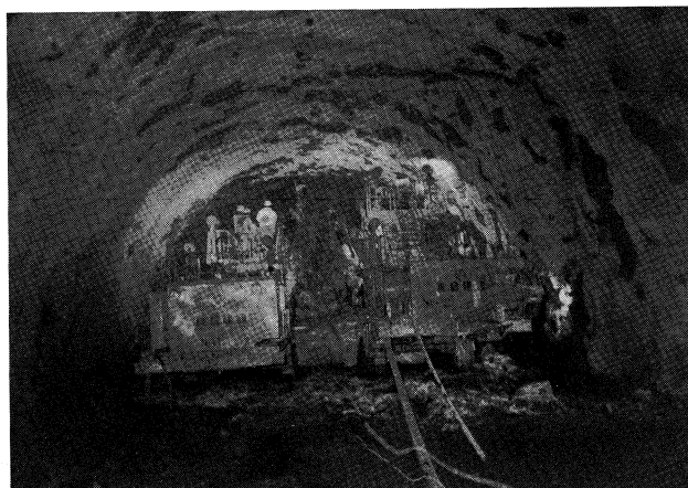
宮窪トンネル掘削状況
