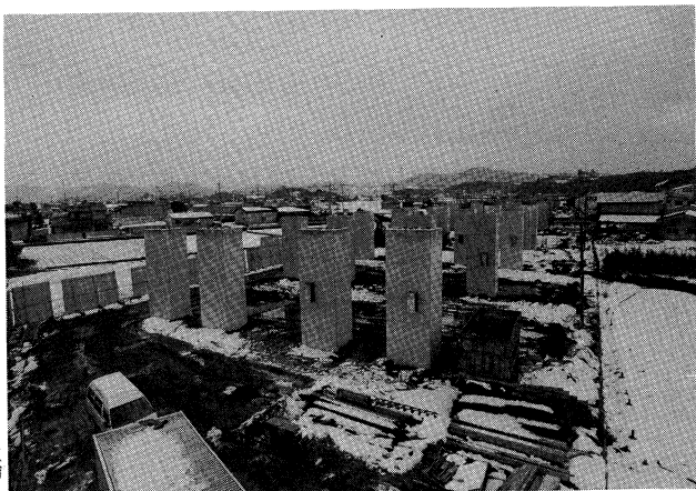
一般国道30号亀山高架橋(その1)工事 (59年2月)
