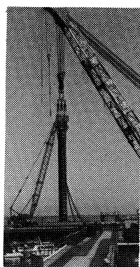
写真-3 鋼管杭打込実験 (バイプロハンマー+W・J工法 \phi 2000 )
