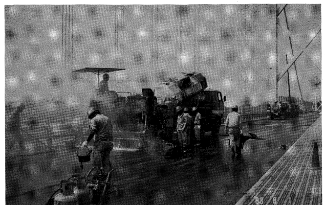
写真-2 グースアスファルトの施工状況
