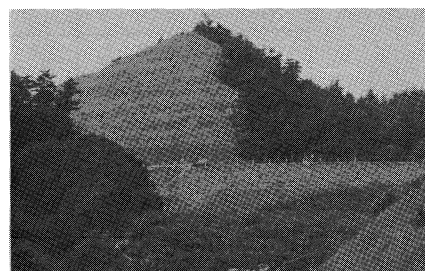
写真-2 植生モルタル施工後
