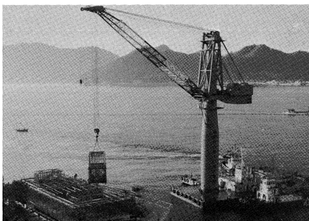
塔 (2 P) アンカーフレーム据付
