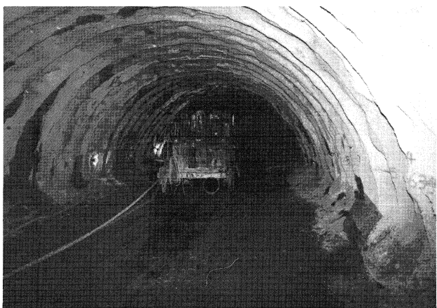
福南山トンネル南工区工事
