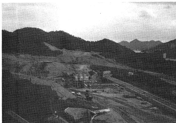
伯方島陸上部工事 (59年12月)
