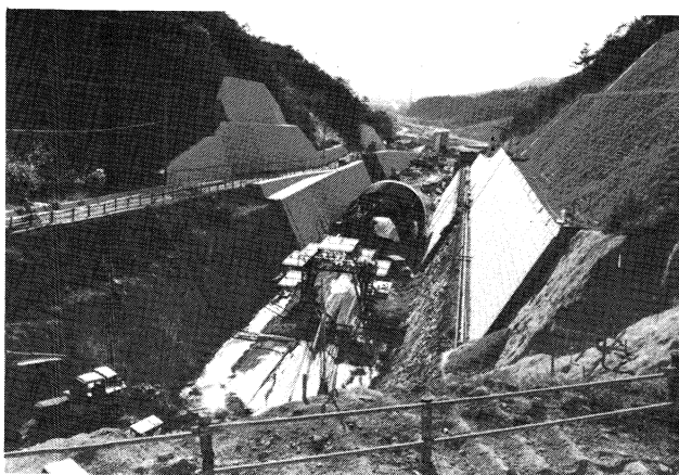
撫養トンネル工事(セントル入坑を待つ)(59年11月)
