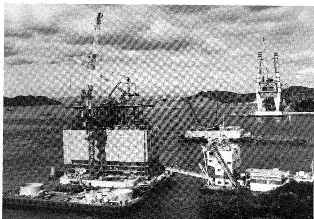
岩黒島下部工(その3)工事 (4P 軀体コンクリート工)
