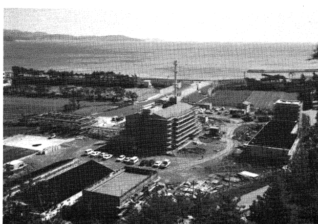
鳴門管理事務所新築工事(全景)
