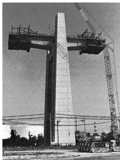
番ノ州高架橋 PC 上部工(その1)工事 (59年11月)
