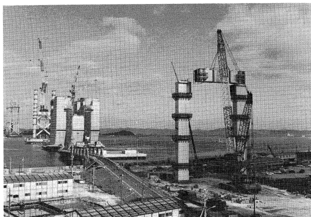
番ノ州高架橋 1 P, 2 P 鋼橋脚工事 (59年12月) (2 P 梁部一括架設)
