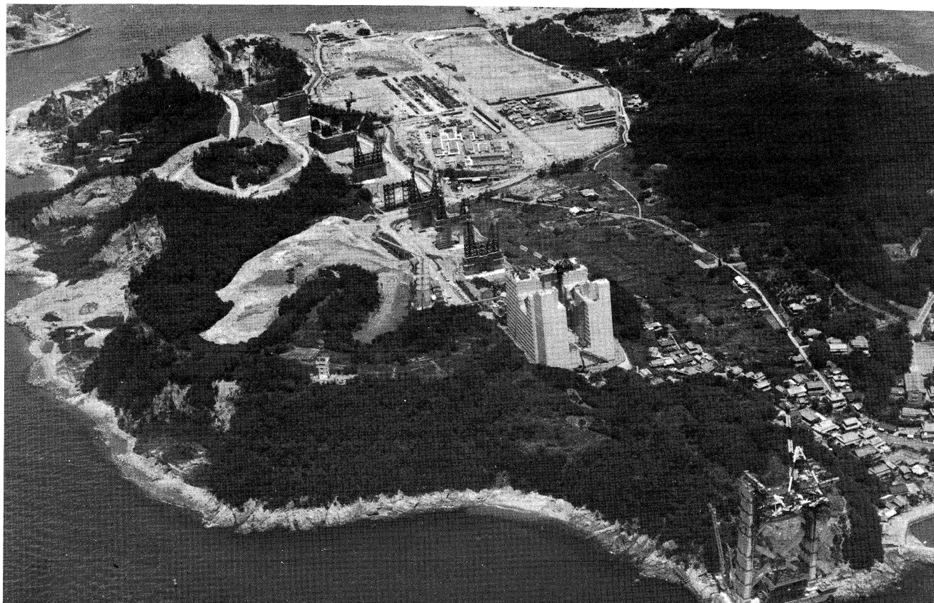
写真1 ケーブル準備工事に着手した1A（昭和59年6月）
