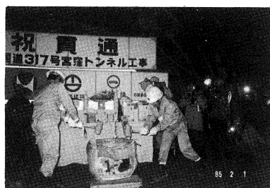
宮窪トンネル貫通 (S60.3)
