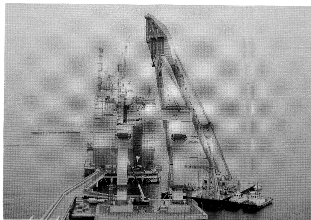
番ノ州高架橋 1 P・2 P 鋼橋脚工事 (60年 2 月)
