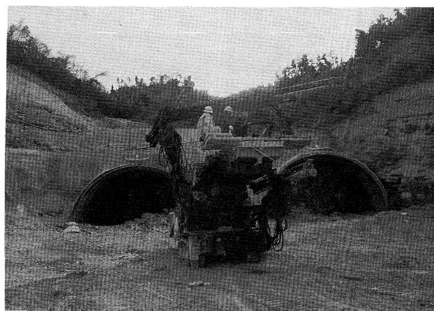
宮窪トンネル北坑口 (60年 1 月) 左側：下り線 (暫定供用線)、右側：上り線
