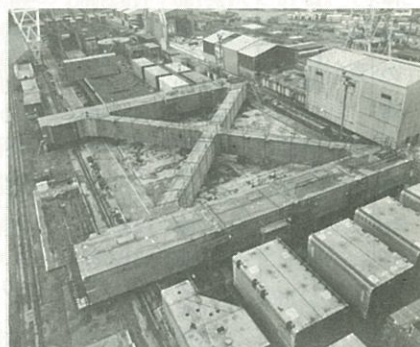
写真-6 斜材の平面仮組
