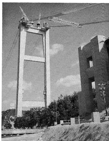
下津井瀬戸大橋ケーブル工事 (60年2月)
