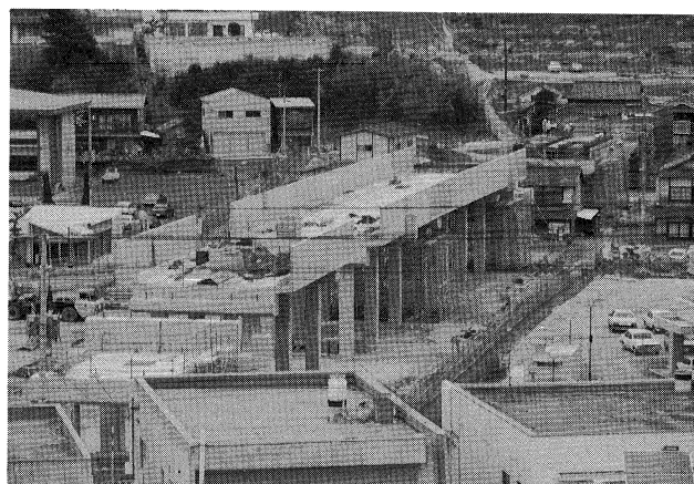
本四備讃線小川 (その2) 工事 (60年2月)
