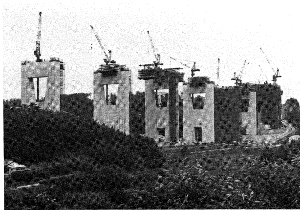
与島高架橋工事(全景)
