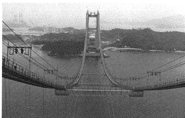
下津井瀬戸大橋ケーブル工事 (60年5月) (キャットウォークシステムの調整)
