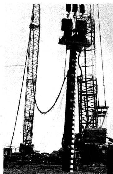
写真-5 バイブロによる杭の建込み
