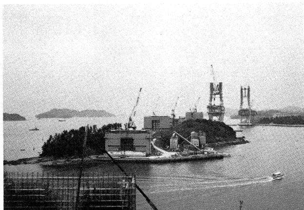
羽佐島地区(その1)工事
