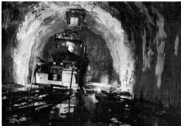
本四備讃線福南山トンネル北工区工事 (60年5月)
