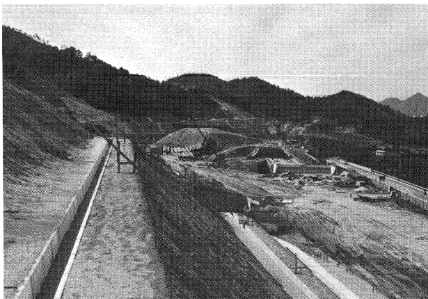
一般国道317号伯方島工事 （60年5月）
