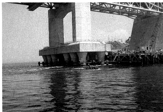
大鳴門橋仮設備撤去工事(その 1) 2P 仮設材撤去
