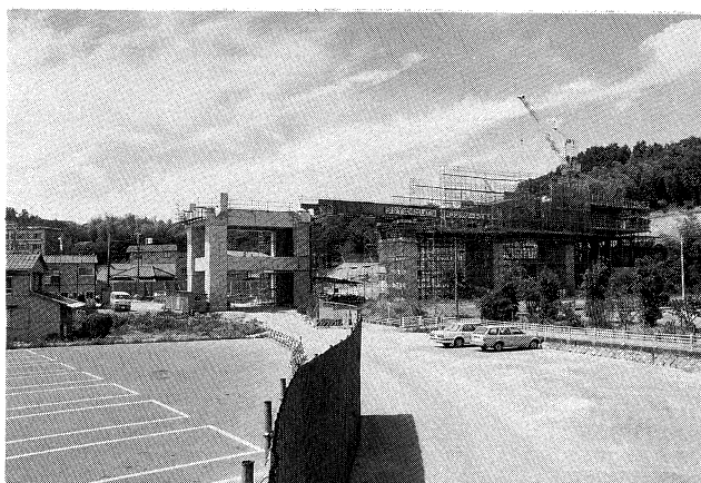
本四備讃線阿津地区PC上部工工事 (60年9月)
