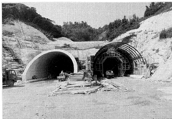
宮窪トンネル工事 (60年9月)
