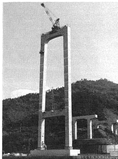
大島大橋塔架設(6P) (60年9月)
