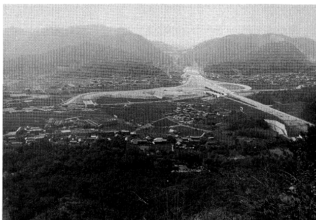
一般国道30号水島 I.C.(その2)工事 (60年9月)
