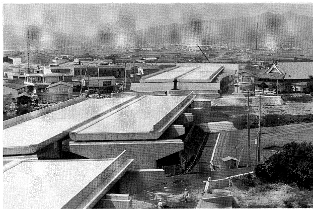
成相川工事より松田工区を望む
