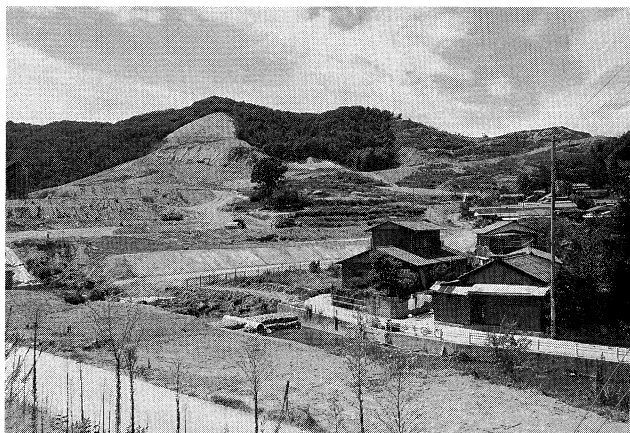
一般国道30号阿津道路(その2)工事 (60年9月)
