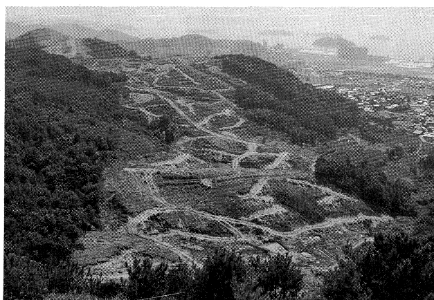
一般国道30号塩生工事 (60年9月)
