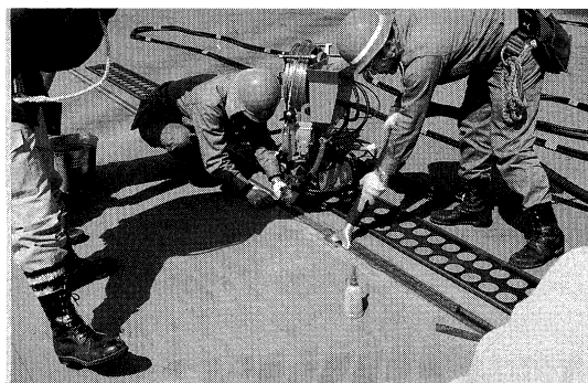
写真一六 鋼床版現場溶接
