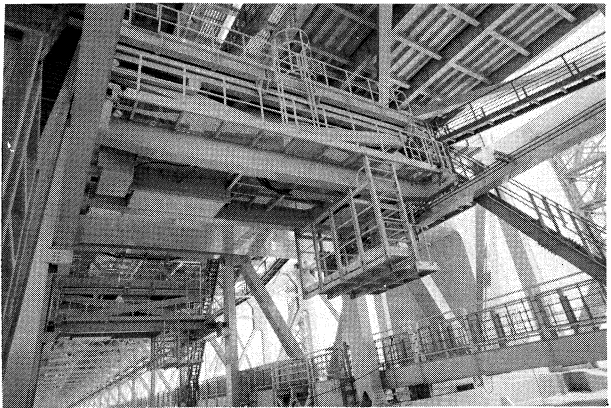
写真－2 桁内面点検補修作業車
