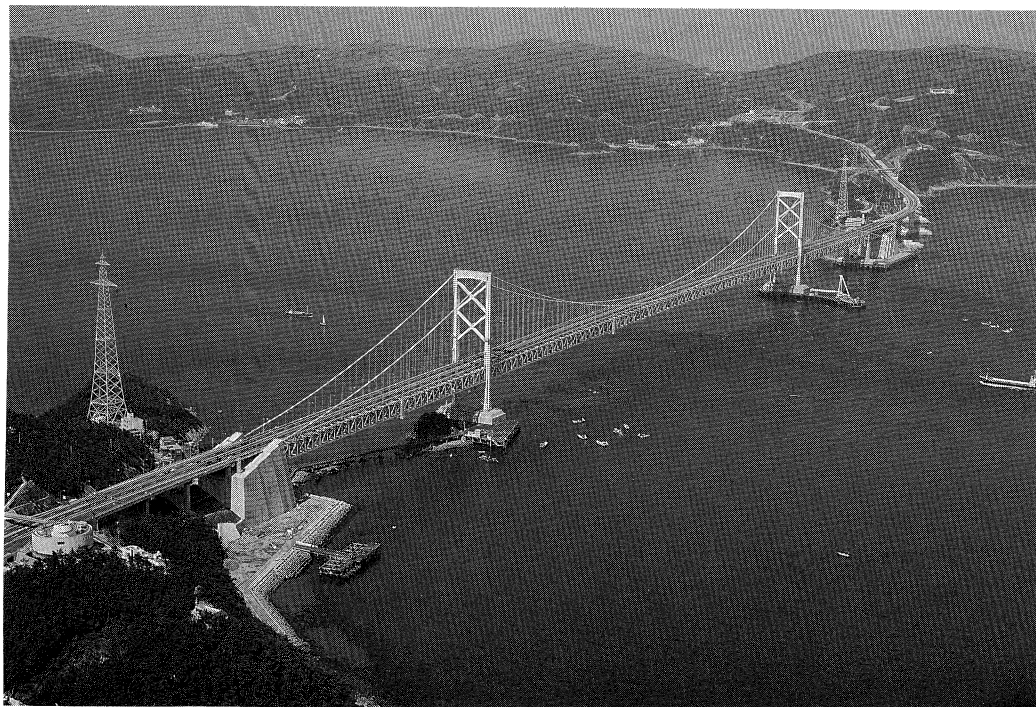
完成した大鳴門橋
