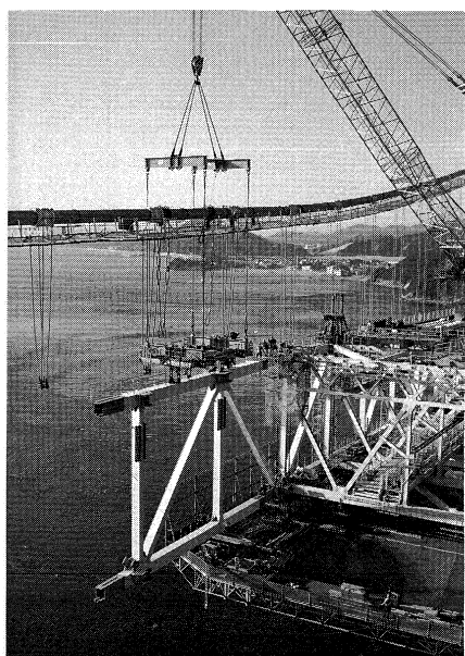
補剛桁架設
