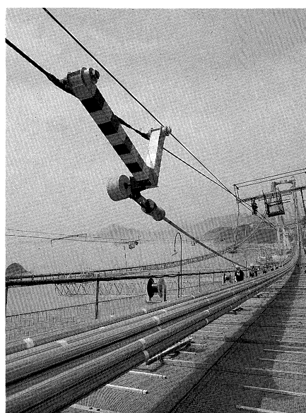
ケーブル架設
