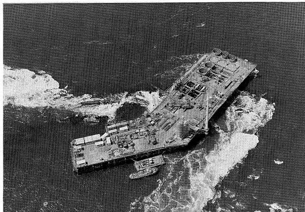
3P多柱基礎工
