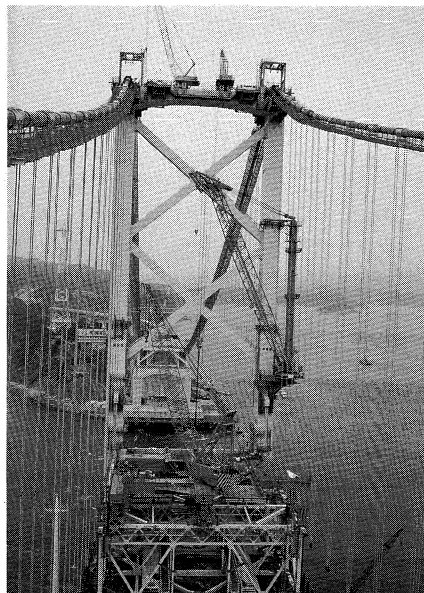
補剛桁架設
