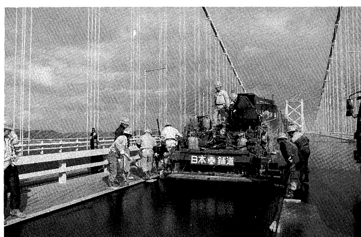
写真-2 グースアスファルトの舗設
