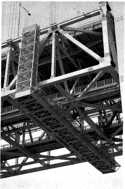
写真－1 桁外面点検補修 作業車
