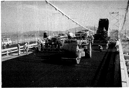
写真-3 改良アスファルトの舗設
