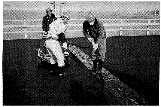
写真-4 注入目地の施工
