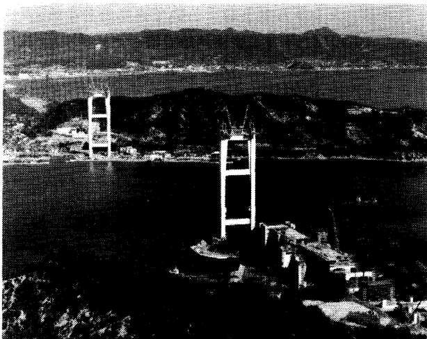
写真-1 下津井瀬戸大橋塔完成後
