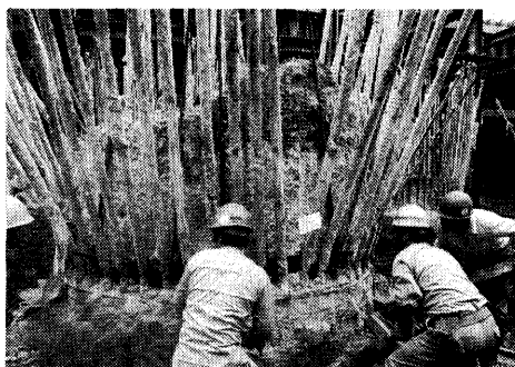
写真－4 杭頭処理状況
