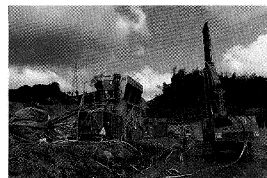
写真-6 オーガー型攪拌工法 機械設備（洲本市中川原町二ツ石）
