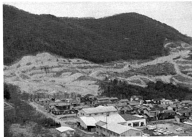
一般国道30号柳田工事 (61年3月)
