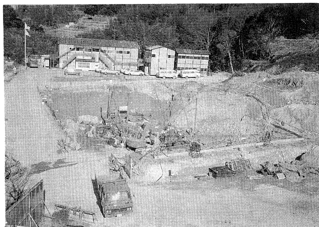
一般国道30号御前道高架橋工事 (61年3月)
