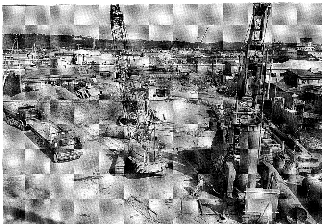
一般国道30号山陽自動車早島西田高架橋工事 (61年3月)
