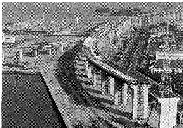
一般国道30号番の州高架鋼上部工架設工事 (61年3月)
