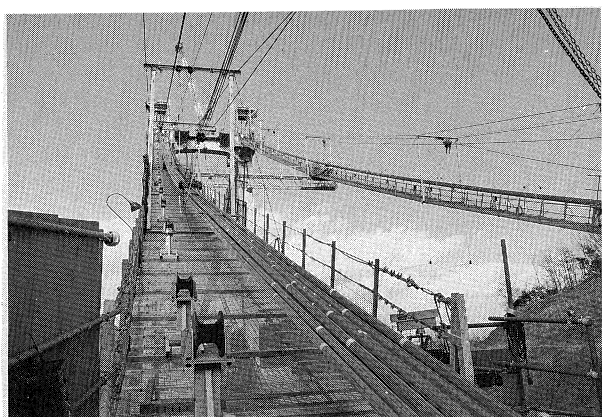
大島大橋ケーブル架設工事 (61年2月)
