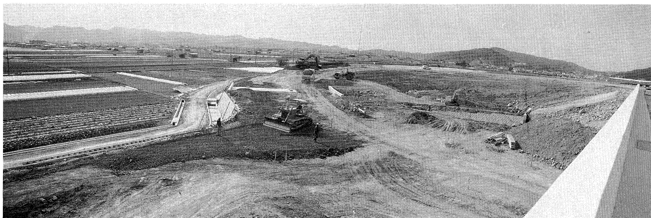
西淡三原 I.C 工事
