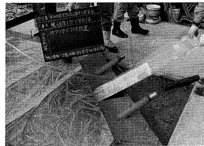
写真-3 注入部型枠とバグパイプ
