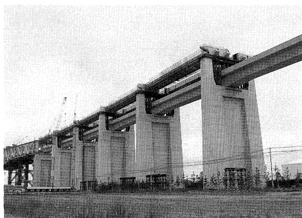
番の州高架橋鋼上部工架設(その1)工事
