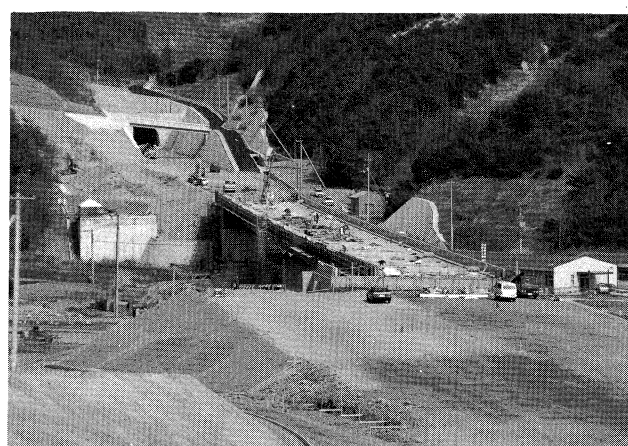
撫養トンネル工事と木津高架橋工事
