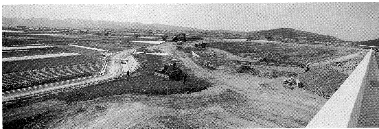
西淡三原 I.C 工事
