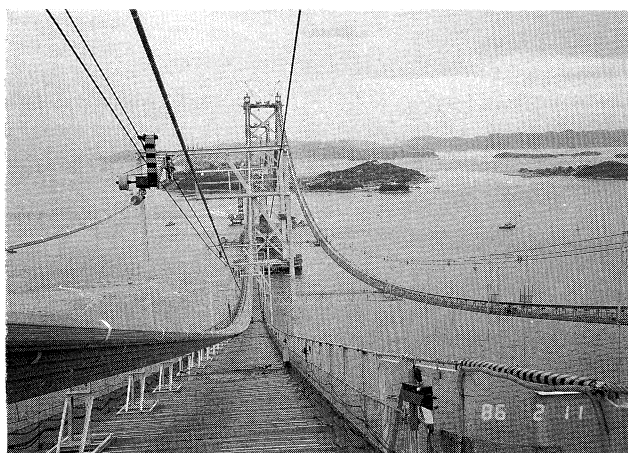
南備讃瀬戸大橋ケーブル架設工事
