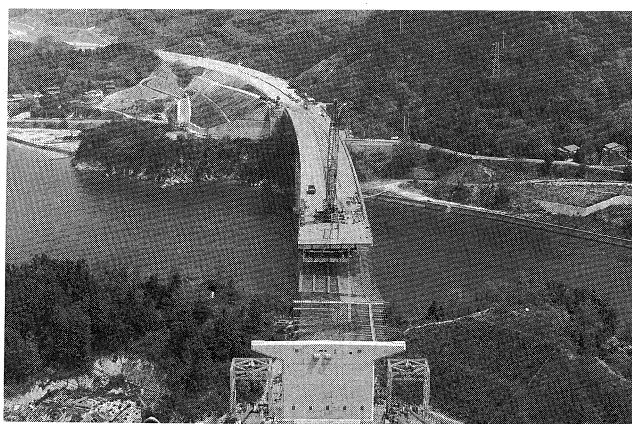
伯方橋(見近島側側径間を除き桁架設完了) (61年6月)
