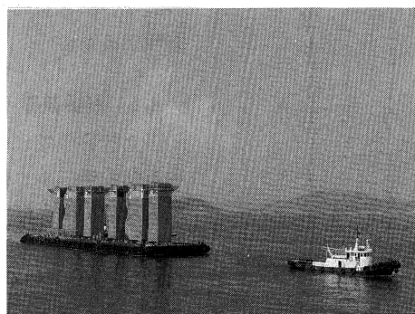
写真-4 台船による部材輸送 (6 P)
