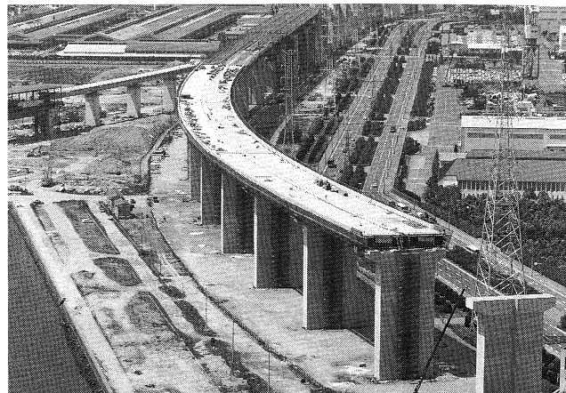
番ノ州道路高架橋の全景(0Pから12Pまで桁架設を完了し、床版工の施工中) (61年6月)
