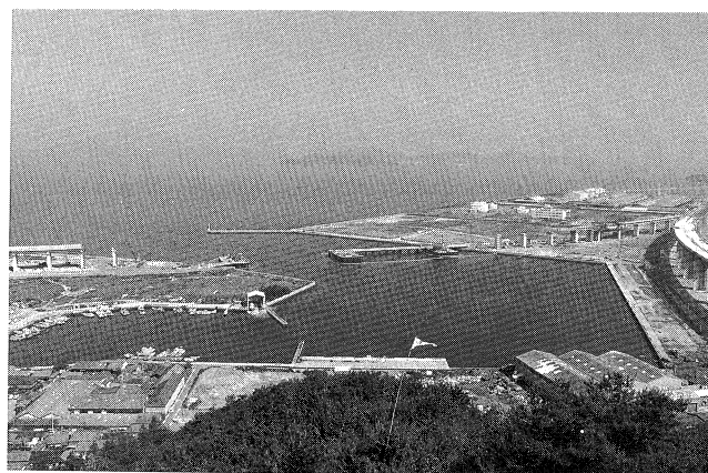
本四備讃線北浦港橋梁全景(海に設ける2P～4Pの連壁は完了し、躯体構築中) (61年6月)
