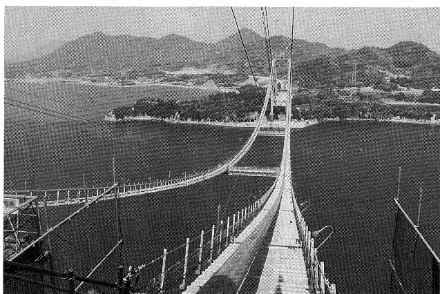
大島大橋ケーブルストランド架設完了(大島より) (61年6月)
