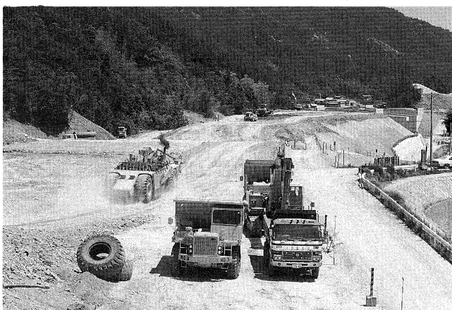
志知奥工事、大型重機による大土工(平積16m 3 モータスクレーバ) (61年6月)
