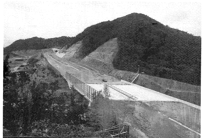
黒山工事 内ノ海から完成した第1三ツ石トンネル方向を望む。④ (61年8月)
