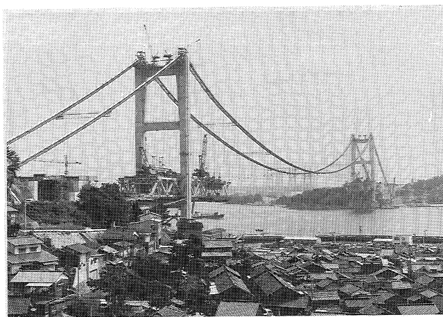
下津井瀬戸大橋 補剛桁の架設進行中（鷺羽山駅より）。（61年9月）
