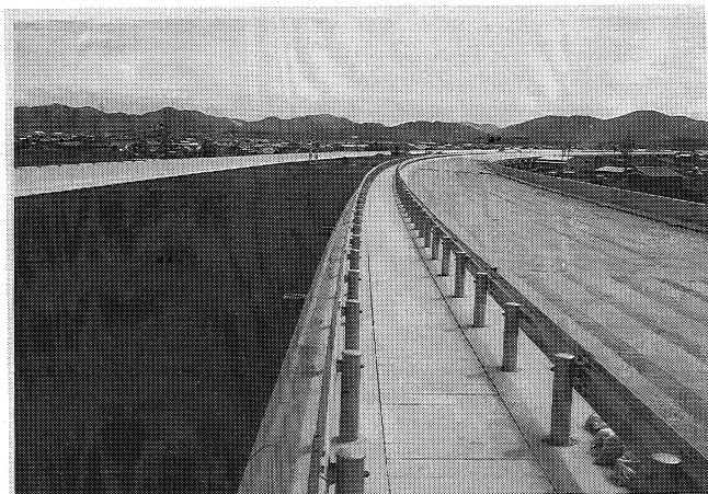
一般国道30号西田高架橋 PC上部工もほぼ概成し、早島I.C.への土運搬のための舗装（下り線）もほぼ完成した。（61年9月）
