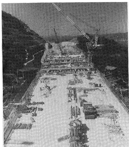
鷺羽山地区（その3）工事 神道山函渠は概成したが、下津井電鉄との交差部は一部工事中。（61年9月）
