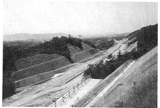
広田工事 土工概成。② (61年8月)
