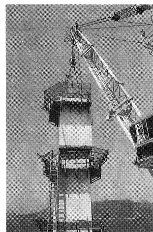
写真-4 塔柱一般部の架設
