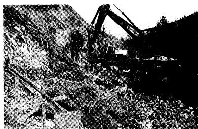
写真-2 ジャイアントブレーカー及び パワースプリッター （ニューマン25X）（BP500）
