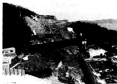
写真-3 仮受桁設置用仮設栈橋 撤去後函渠掘削開始
