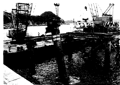
写真-3 鋼管杭撤去状況
