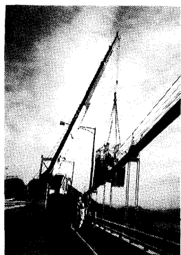
写真-8 ケーブル検査車の設置
