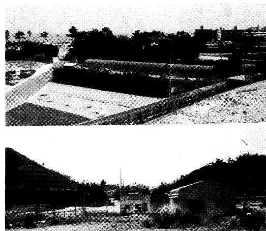
写真-1 工事前・後の地形改変状況
