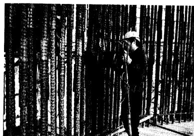
写真-4 D5I圧着作業状況
