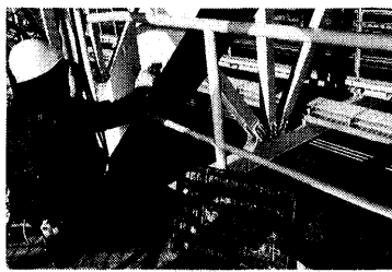
写真－4 側面作業台上での部分補修塗装作業
