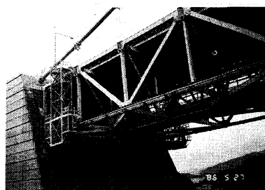
写真一 補剛桁点検補修 作業車
