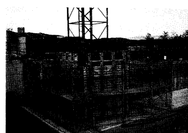
写真-6 特殊コンクリートフォーム を使用したスライド型枠
