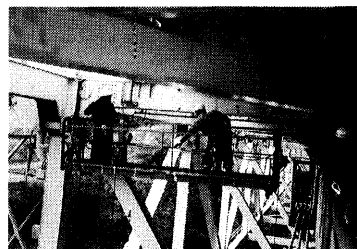
写真－6 ゴンドラによる部分補修塗装作業
