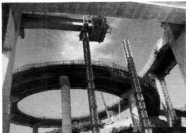
写真-4 ランプ桁の張出し施工
