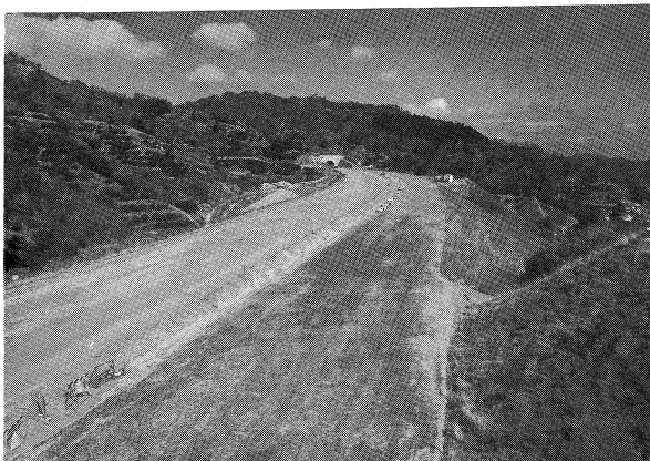
舗装工事中的大島側陸上部（遠方宮窪トンネル）。（62年3月）
