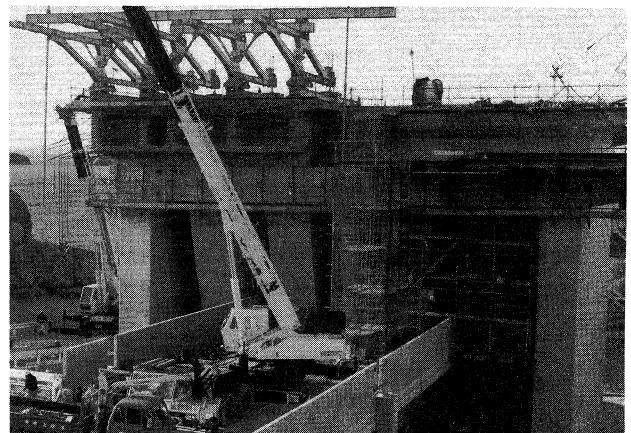
写真-6 YB4P 逆張出し施工
