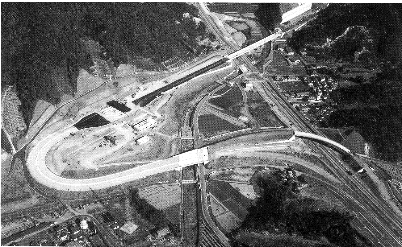
鳴門 IC（舗装工施工中）、上空より眺む。（61年12月）
