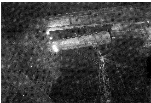
番の州道路高架橋、県道高差点において夜間架設を実施。 （62年3月）
