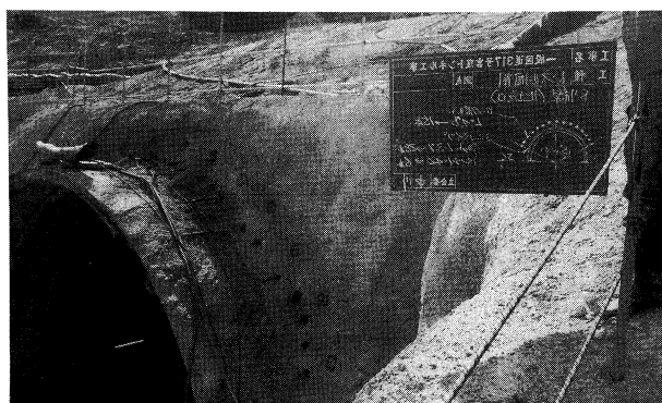
写真-1 坑口の補強
