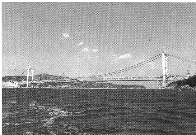
下津井瀬戸大橋、補剛桁架設中（4月中旬閉合予定）。 （62年3月）
