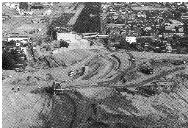
一般国道30号 御供所・常盤工事、坂出北 IC の盛土造成中で、奥に見える IC 高架橋の鋼桁架設完了。 （62年3月）
