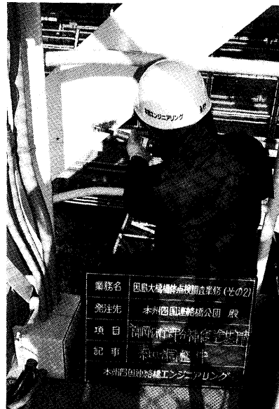
写真-26 素地調整状況
