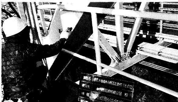
写真-27 下塗作業状況
