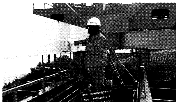
写真ー4 付着塩分測定
