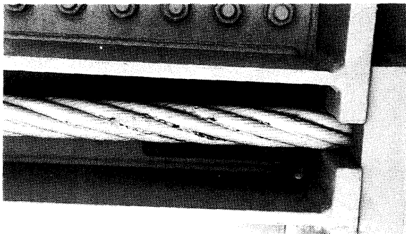
写真-25 ハンガー定着部の変状
