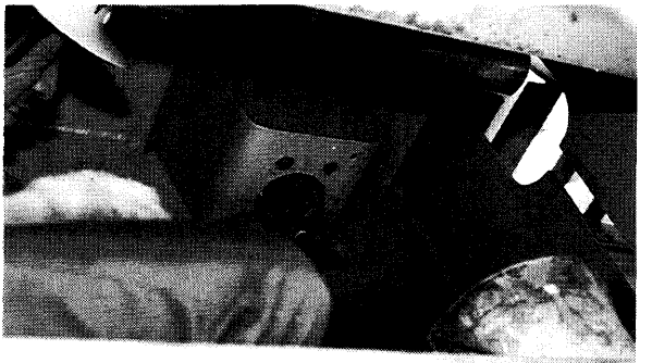
写真-24 鋼床版ひりび内の鳥の巣
