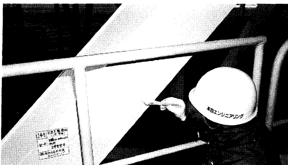
写真-28 上塗作業状況
