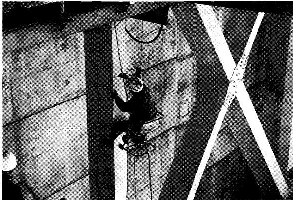
写真-36 チェア型ゴンドラによる補修作業
