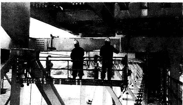
写真-31 ゴンドラ（デッキタイプ）による補修作業
