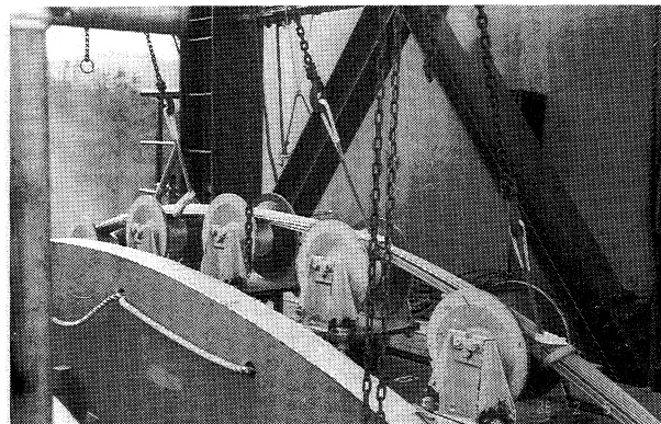
写真-7 塔頂サドル脇ローラーを通過中
