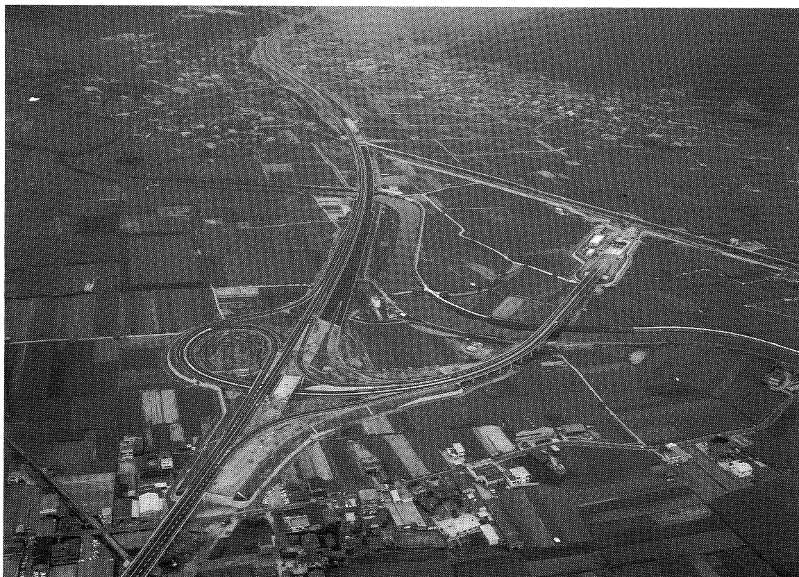
西淡・三原インターチェンジ（工事既成）
