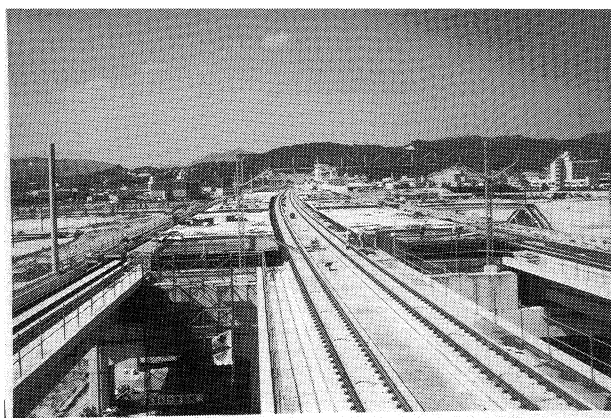
本四備讃線・児島駅（軌道敷設を完了、現在乗降場施工中）（62年8月）
