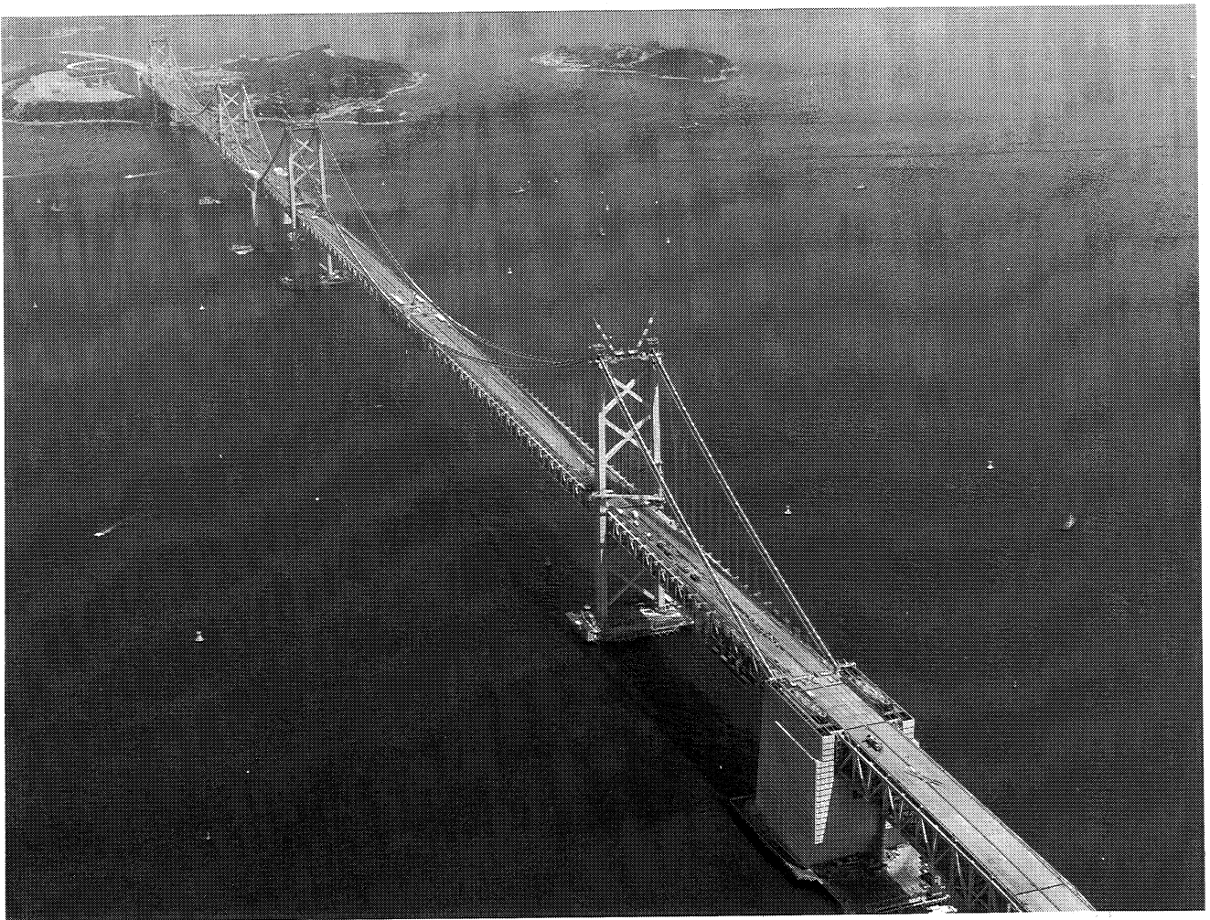
南備讃瀬戸大橋（8月12日最終ボルト締結）
