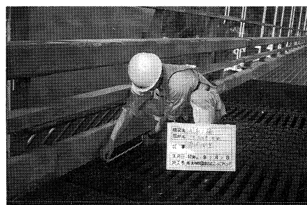
図-10 伸縮装置移動量、遊間量測定位置(中央径間)
