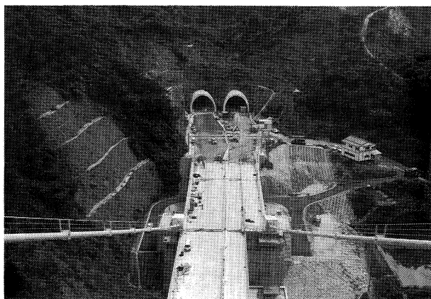
大島大橋の大島側塔頂より見た宮窪トンネル坑口付近 （62年8月）
