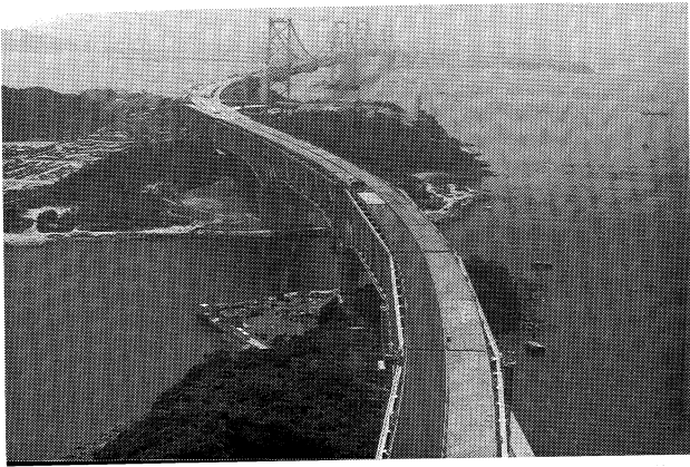
与島橋（床版工を完了、現在舗装工施工中） （62年8月）
