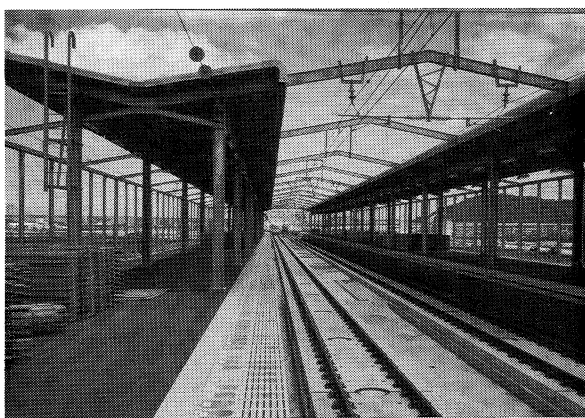
予讃線宇多津駅（軌道敷設及びプラットフォームを完了、 現在防風工施工中）（終点側から）（62年8月）
