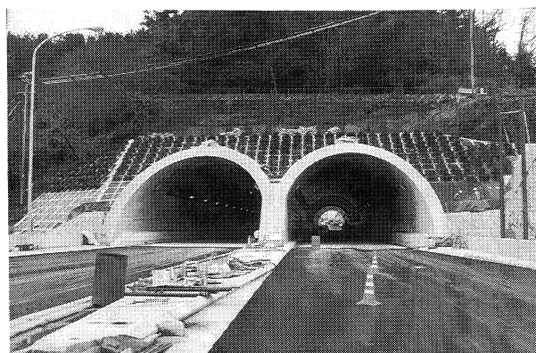
鷲羽山トンネル（道路トンネルの北坑口より。修景緑 化工事施工中） (62年11月)
