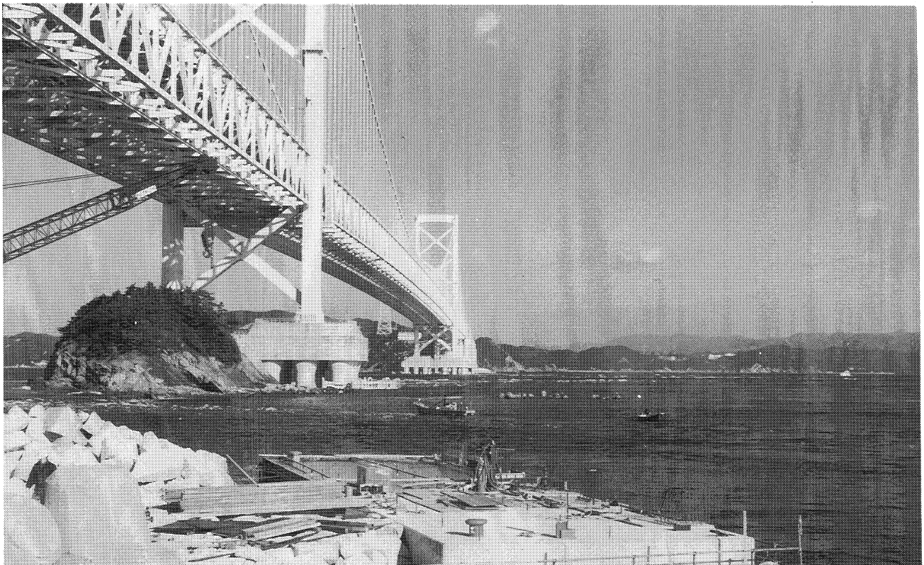
大鳴門橋仮設備撤去工事（その2）（県有栈橋復旧工）
