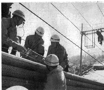
写真-5 現場継手作業 (ストランド構成ワイヤ 始末端継手)
