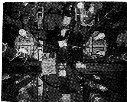
写真-12 アンカースパン 張力調整
