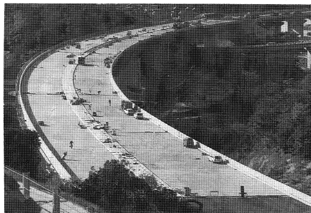
菰池高架橋（床版工完了） (62年11月)
