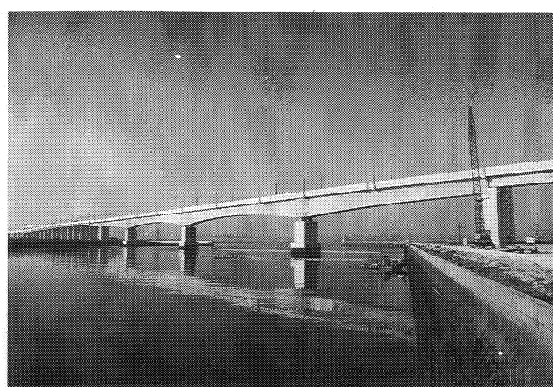
本四備讃線北浦港橋梁（橋梁付属物工完了） (62年11月)
