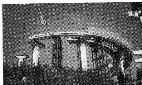
写真-4 ループ橋の架設状況
