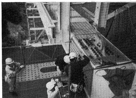
写真-5 11パネルの下弦材添接部と連結ガイド
