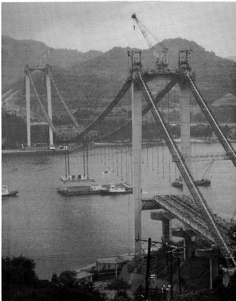
大島大橋補剛箱桁の直下吊上げ架設 (61年9月)
