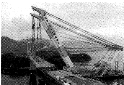
写真-1 大ブロック架設
