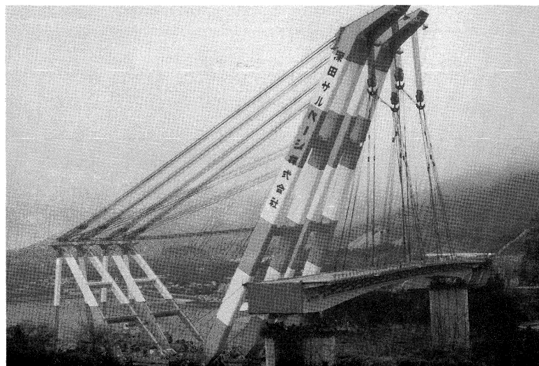
伯方橋の箱桁大ブロック架設
