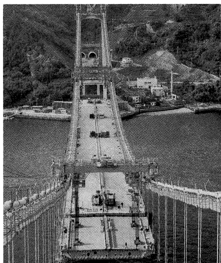
大島大橋補剛箱桁の架設 (61年11月)
