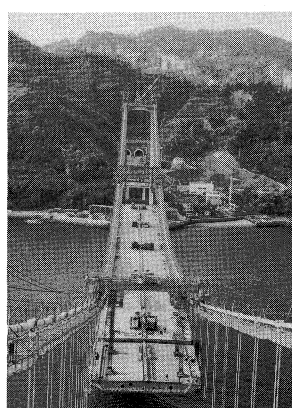
写真-4 吊上げ中
