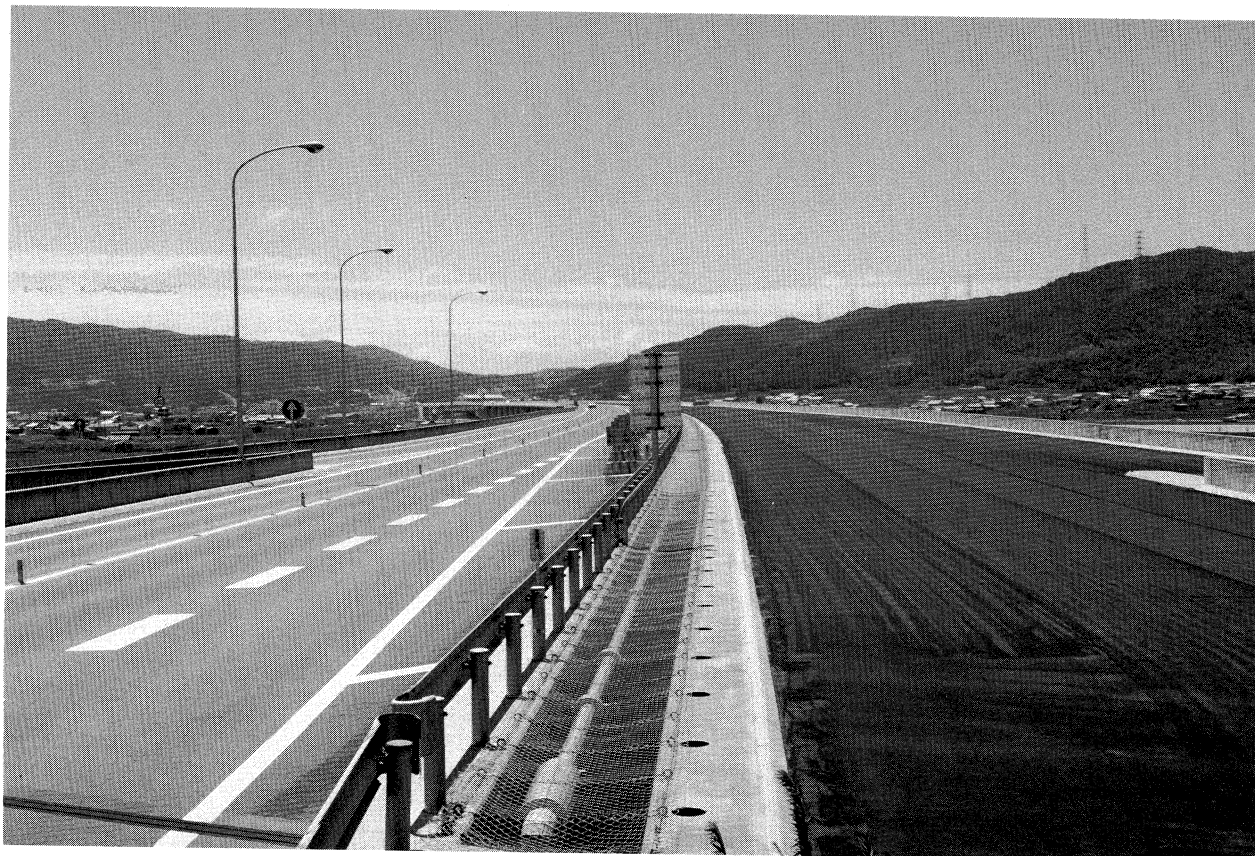
西淡・三原舗装工事（西淡・三原ICより鳴門方向を望む）
