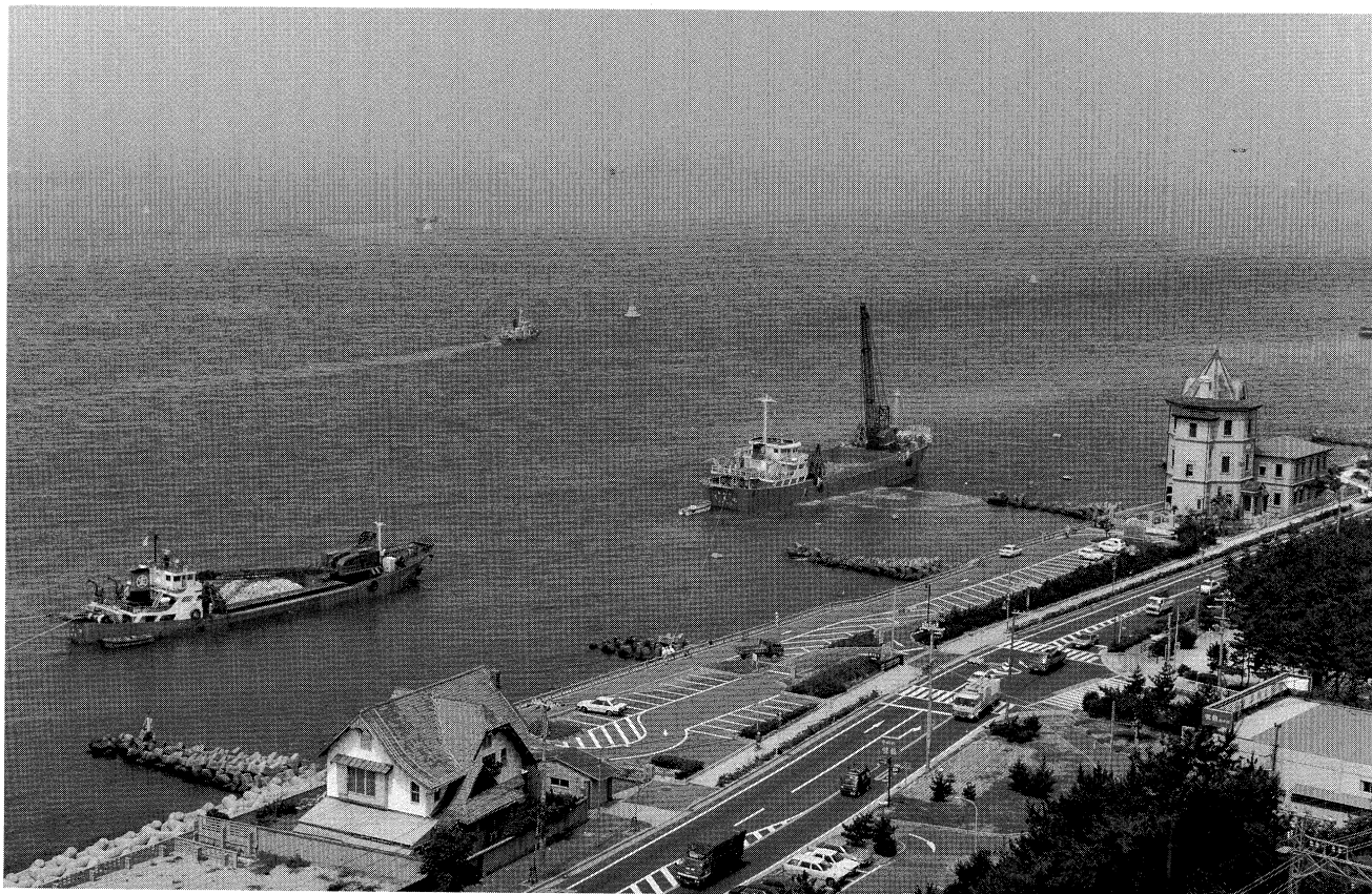
明石海峡大橋1A下部工（その1）工事（作業基地埋立工事）
