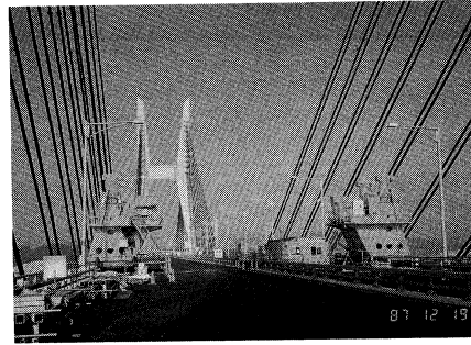
写真-1 起振機設置 状況 (L/4 点)
