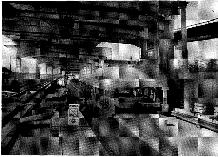
写真-6 自走式スラブ 運搬敷設車
