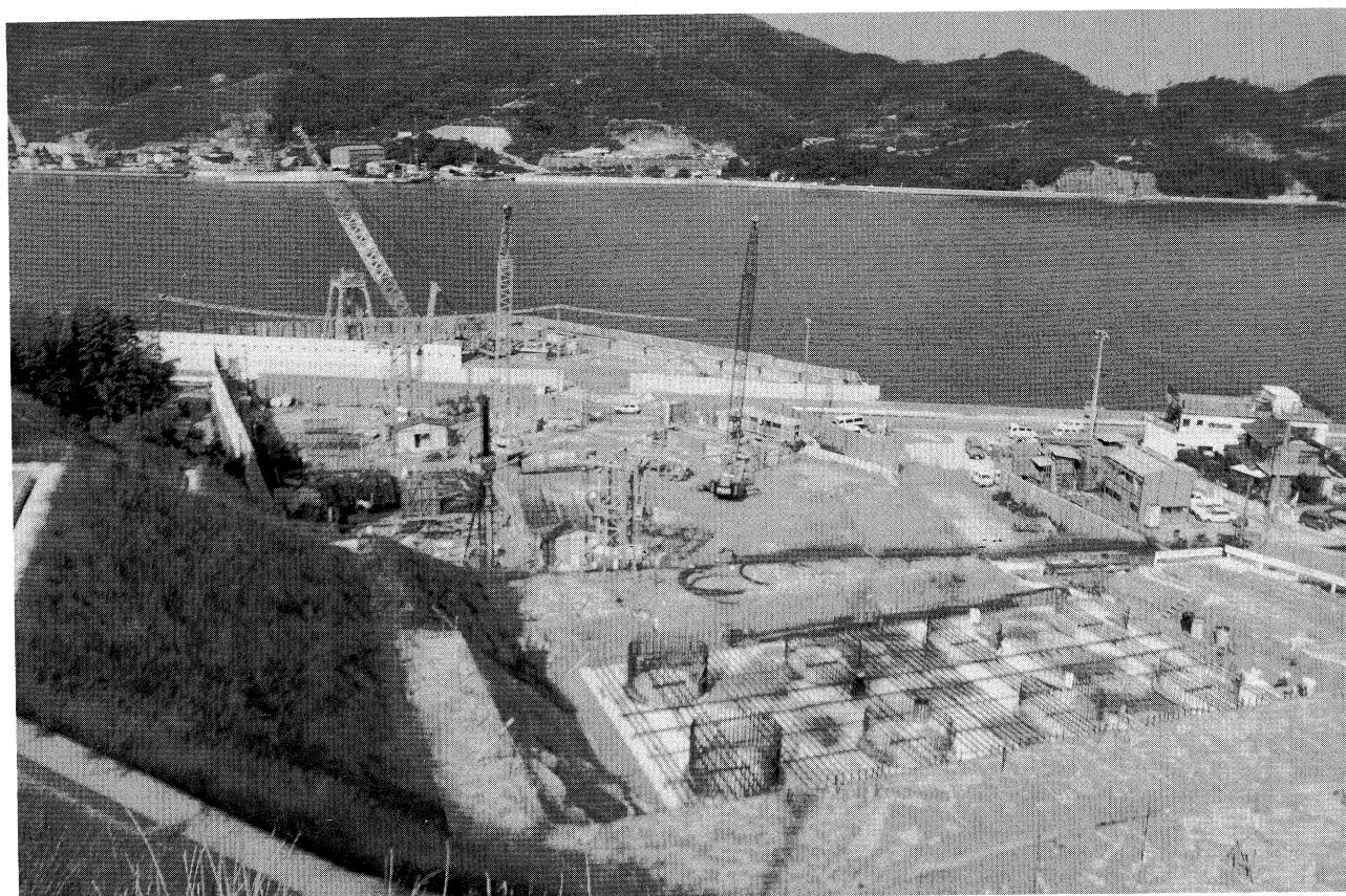
生口橋の因島側下部工工事
