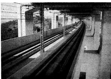
写真-2 スラブ軌道
