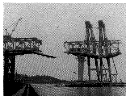
写真-4 フロートングレーン による大ブロック架設
