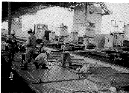
写真-8 CAモルタル 注入
