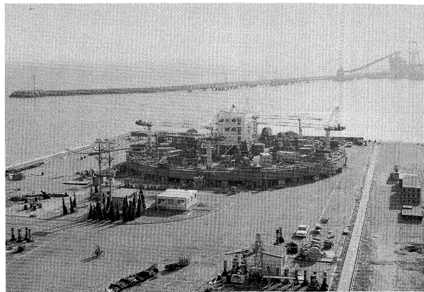
明石海峡大橋2P鋼ケーソン製作（艀装架台） （63年11月）
