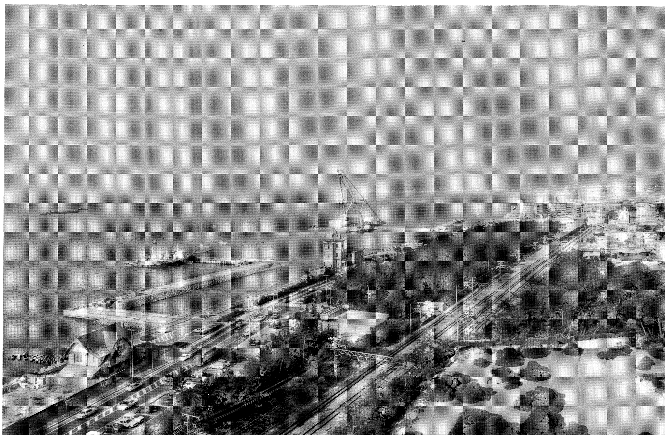
明石海峡大橋1A下部工（その1）工事（舞子作業基地締切用護岸工）
