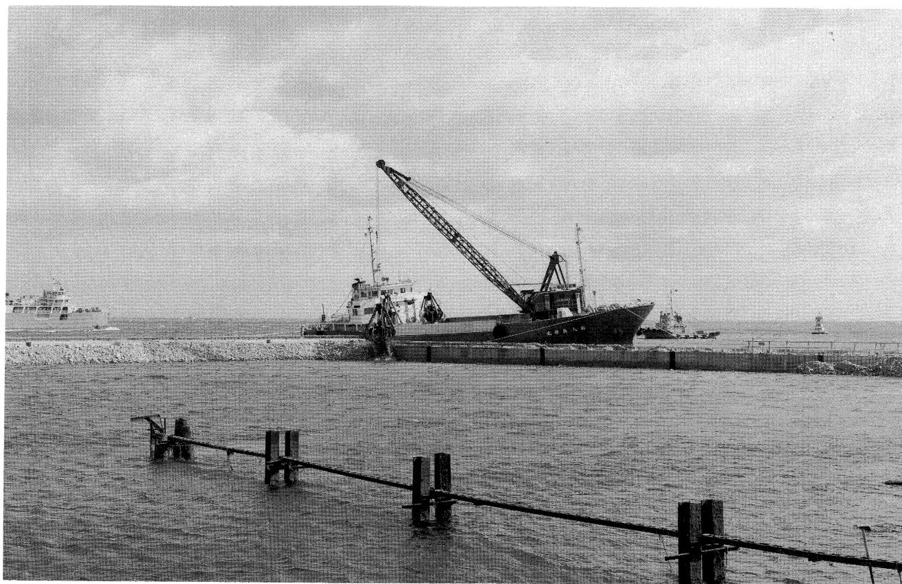
明石海峡大橋4A下部工（その1）工事（松帆作業基地締切用護岸工）
