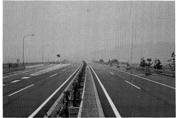
西淡三原舗装工事（西淡三原IC付近四車線化工事完了） （元年2月）
