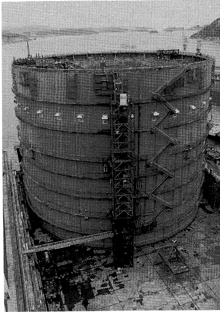
明石海峡大橋 3P 鋼ケーソン 製作（最終ブ ロック搭載完了） （元年2月）
