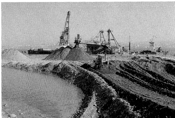
明石海峡大橋 4A 下部工（その1）工事（埋立中） （元年2月）
