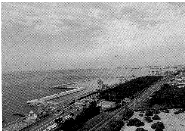
明石海峡大橋 1A 下部工（その1）工事（コンクリート ケーソン設置完了） （元年2月）
