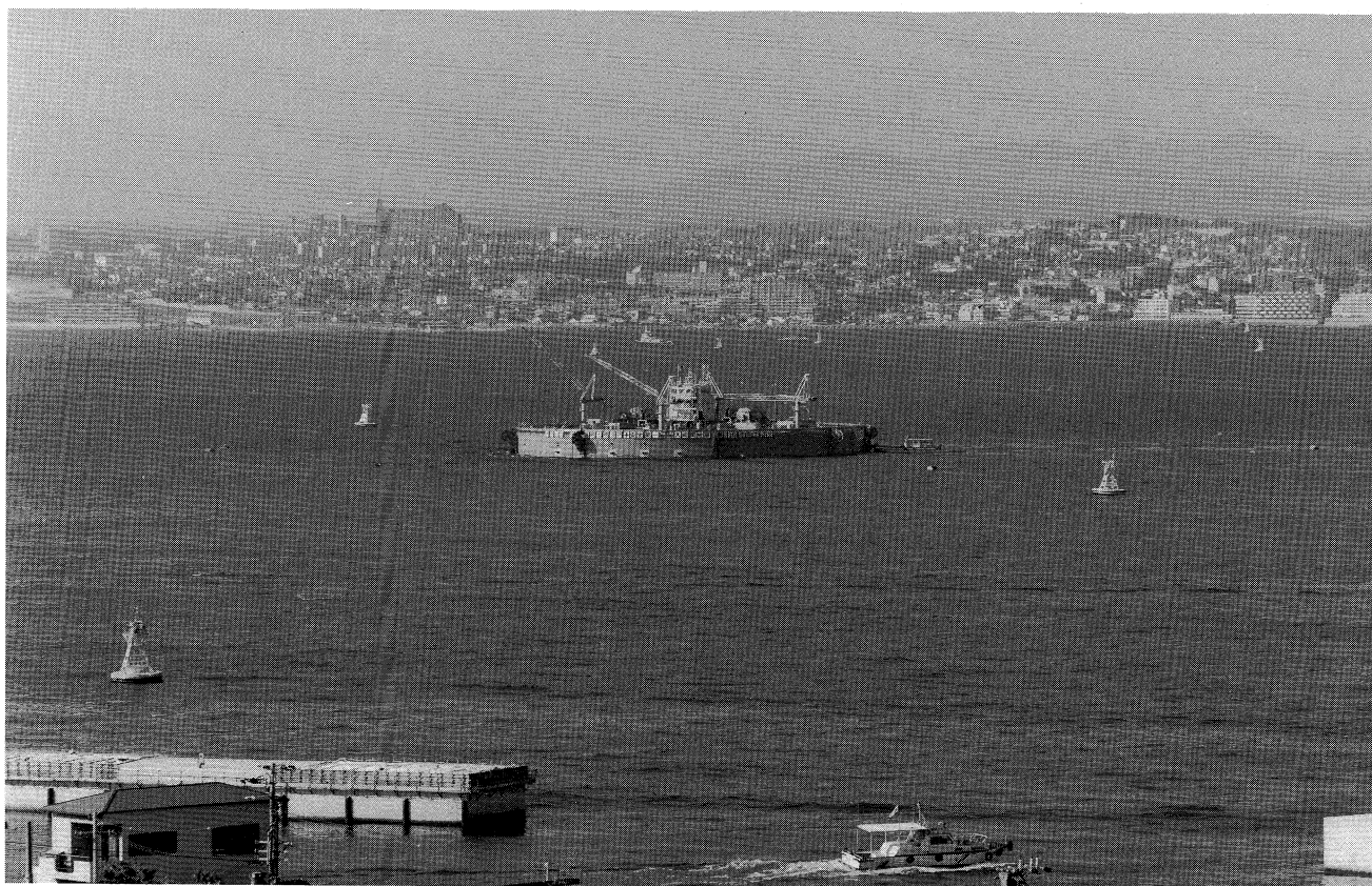
明石海峡大橋3P鋼ケーソン曳航中(淡路島から神戸方向を望む)
