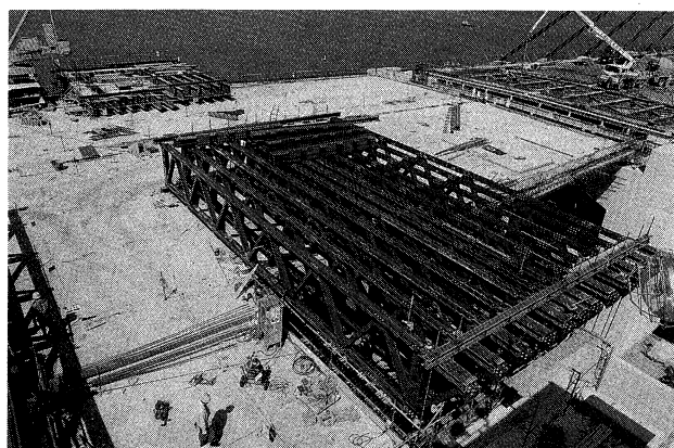
写真-3 拡幅部の施工
