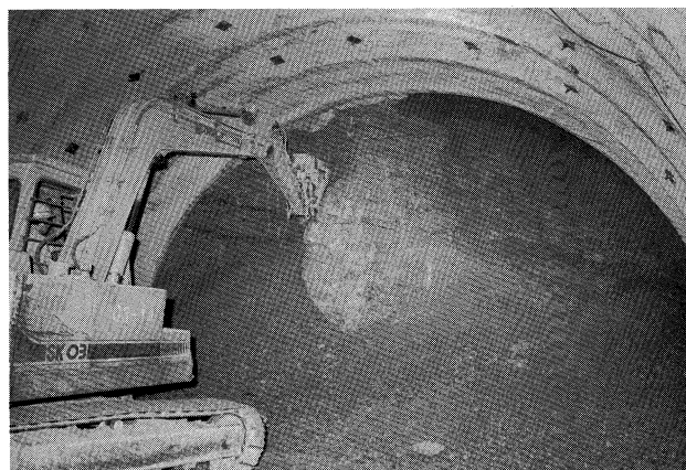
舞子トンネル試験坑地質調査（その2）（切羽断面） （元年6月）
