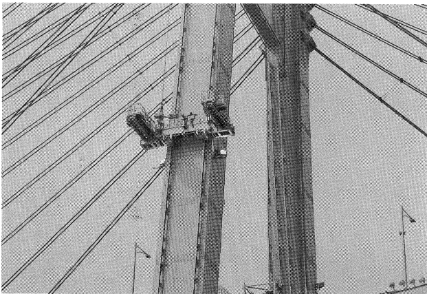
塔外面作業車（櫃石島橋）
