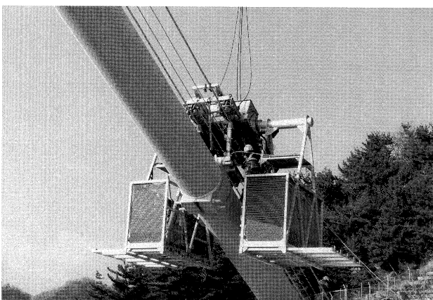
ケーブル作業車（下津井瀬戸大橋）
