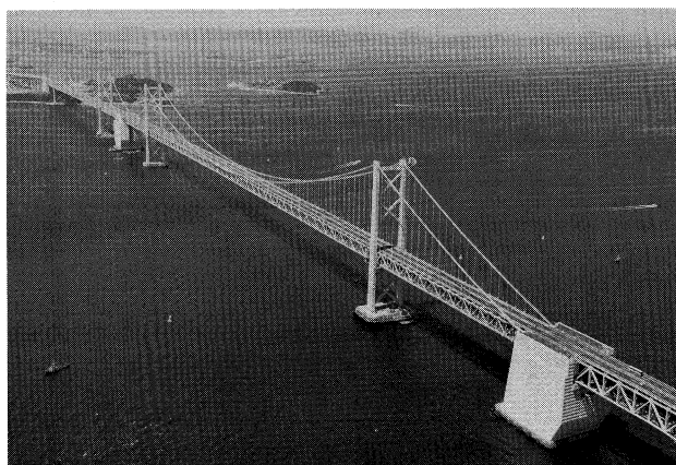
写真-1 南北備讃瀬戸大橋
