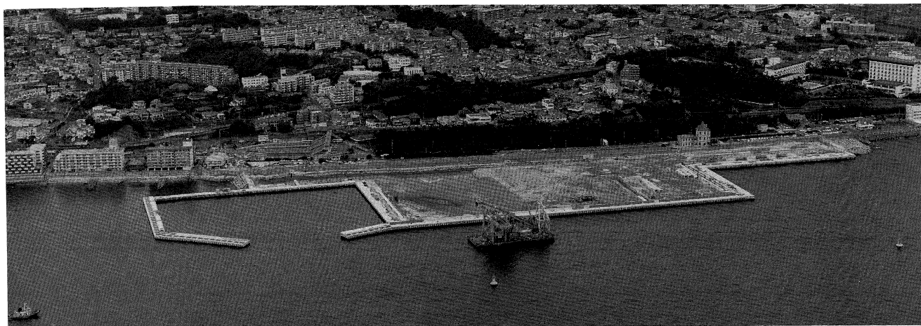
明石海峡大橋1A下部工（その1）工事 埋立工施工中
