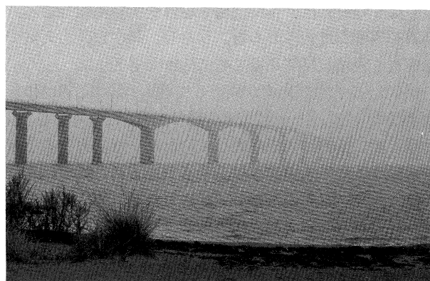
写真-5 橋長6070mのエランド橋
