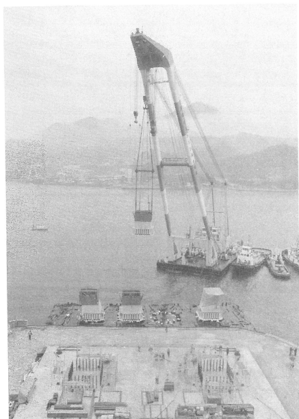
生口橋 2P 塔基部の架設 (元年7月)
