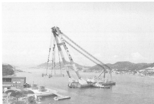
生口橋 3P 塔中間部の架設
