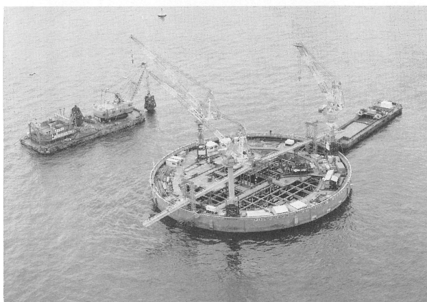
明石海峡2Pズリ処理作業中
