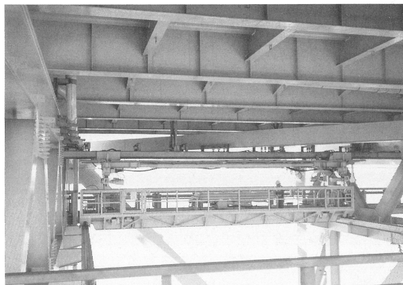
桁内面作業車（櫃石島橋）
