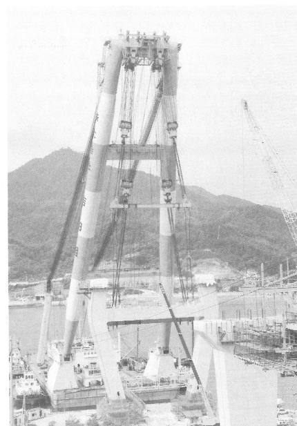
生口橋 2P 塔中間部の架設 (元年8月)
