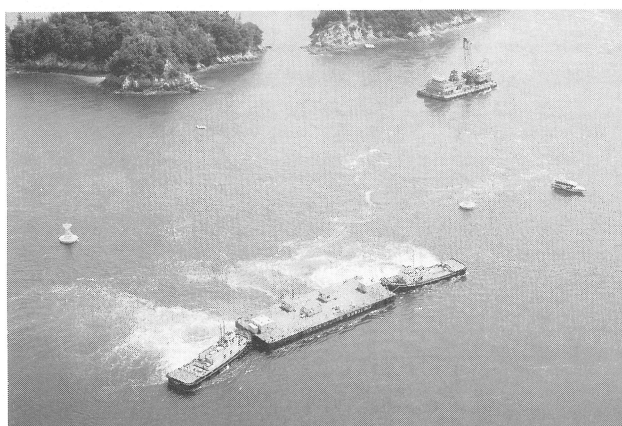
来島海峡における操船性確認試験、グラブ浚渫船は来島大橋 5P 地点での岩盤掘削試験 (元年8月)
