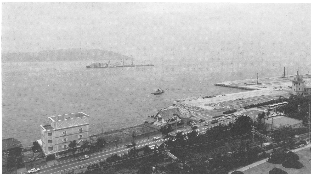
明石海峡大橋2P鋼ケーソン内水中コンクリート打設作業を神戸側より望む
