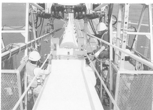
ケーブルバンドボルト軸力測定 (近景)
