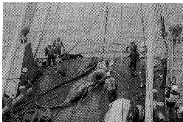
写真-2 係留索の設置作業
