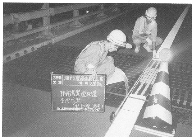
伸縮装置遊間量の測定
