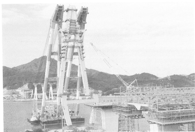
生口橋2P塔上部ブロックの架設
