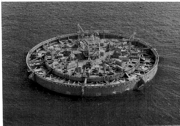
写真-6 ケーソン沈設設備の全景
