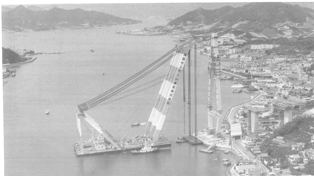
生口橋2P塔上部ブロックの架設完了
