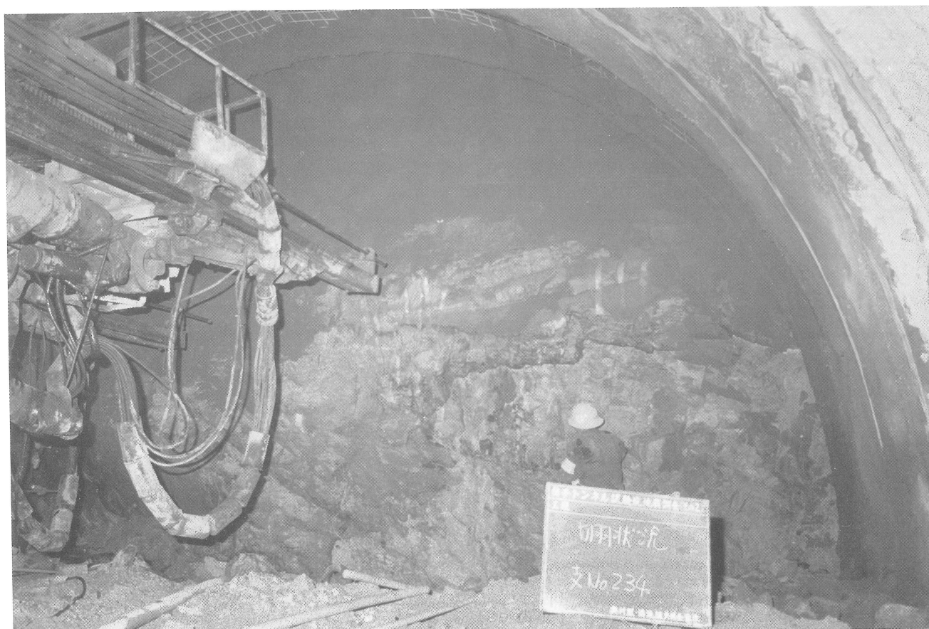
舞子トンネル試験坑地質調査（その2）花崗岩部切羽断面
