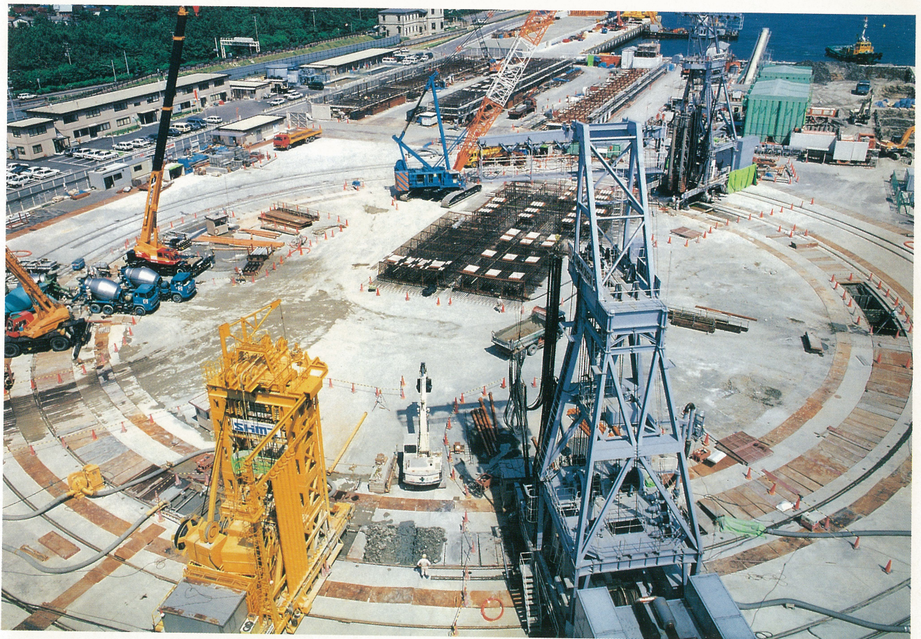
明石海峡大橋 1A 地下連続壁施工状況
