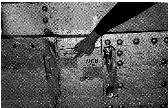
写真-12 E11橋脚上の高欄に記された移動量、右側（サンフランシスコ側）へ、5 1/2インチ（約14cm）復旧のために移動されたことがわかる。UCB,EEERCはカリフォルニア大学バークレー校、地震工学研究センター。
