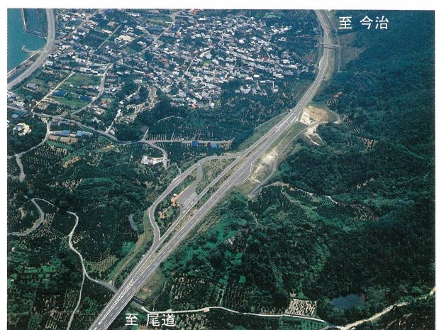
西瀬戸中央自動車道 上浦パーキングエリア
