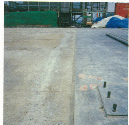
同左接合部目地の弾性シール材完了 （2年5月）
