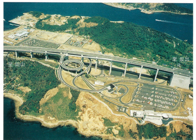
瀬戸中央自動車道 与島パーキングエリア
