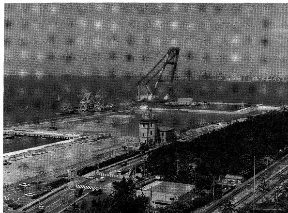
写真-1 舞子作業基地の施工状況
