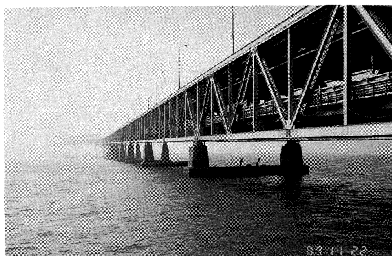
写真-2 ベイブリッジ・イーストサイド。オークランド地区から見たイーストサイド。屈曲部の先、上路がスルータイプとなる直前がE9強脚部。手前がE22橋脚、E17～E23橋脚はコンクリートである。
