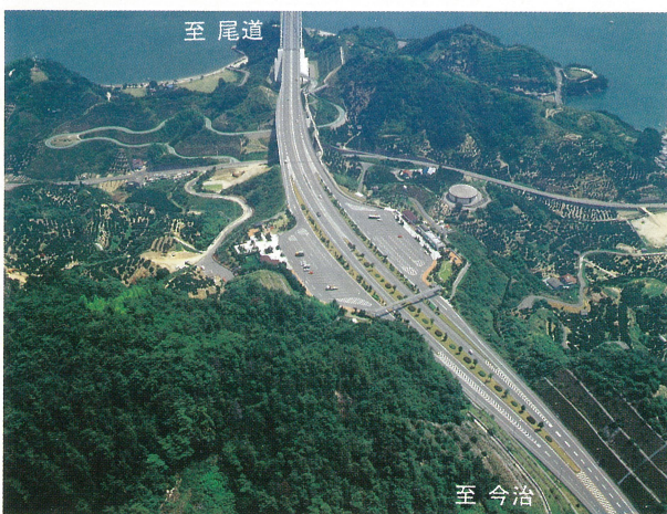
西瀬戸中央自動車道 大浜パーキングエリア
