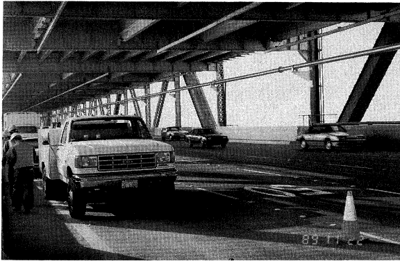
写真-9 再開通後のベイブリッジ下路部である。斜材のない部分がE9橋脚部。復旧された高欄が新しい。
