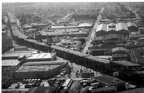
写真-16 サイプレス高架橋の被害状況。26番通交差点部から南側 (写真の左側) の航空写真で、24番通交差点部、ウエストランド通交差点部およびその南側の18番通交差点部までの高架橋の崩壊状態が良く分かる。(NISTのH.S.Lew博士提供の写真)
