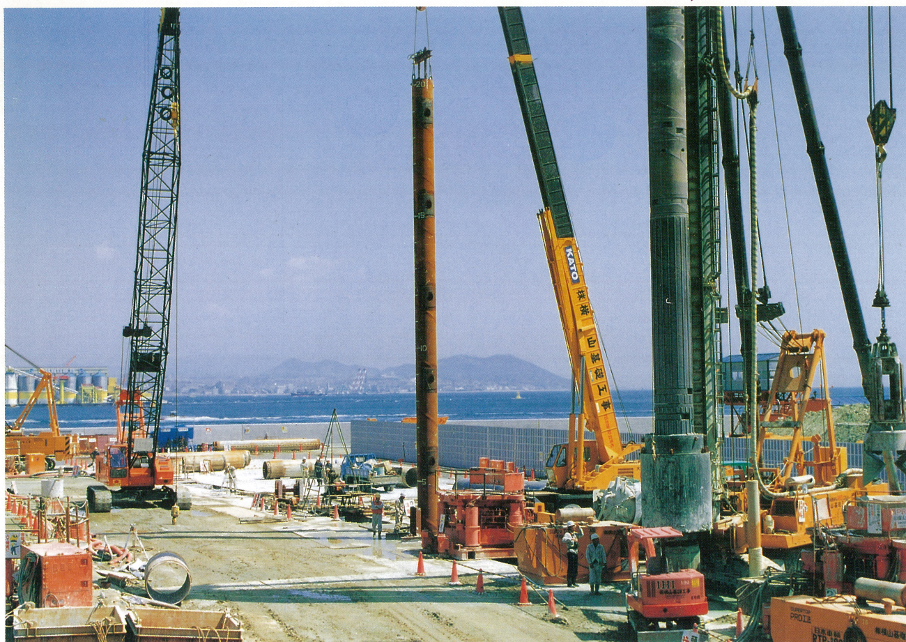
明石海峡大橋 4A 土留工有芯杭施工状況
