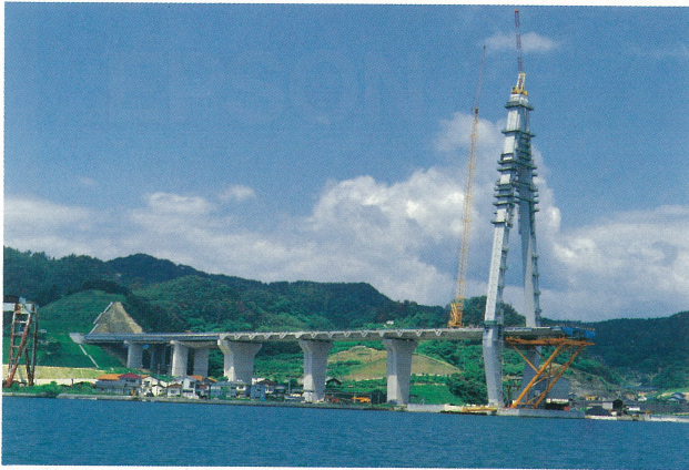
生口橋の塔、PC 上部工、取付高架橋の概成（生口島側） （2年6月）
