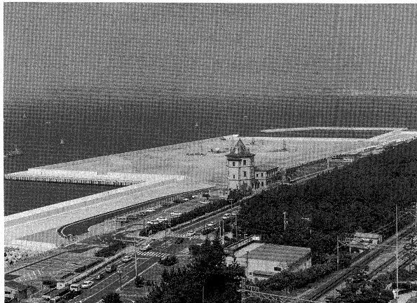
写真-3 舞子作業基地の完成写真
