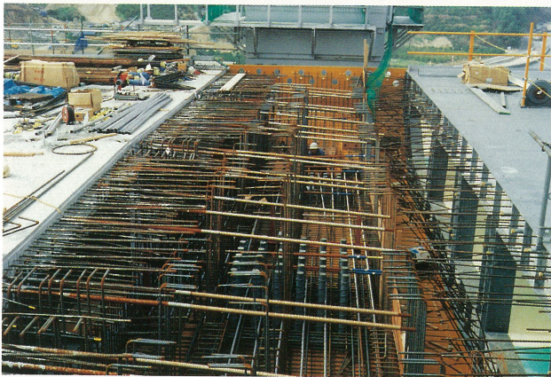
生口橋PC桁・鋼桁接合部の鉄筋組立て（右：鋼桁）＊巻末 技術ニュース参照 （2年3
