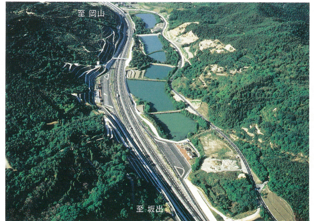
瀬戸中央自動車道 粒江パーキングエリア
