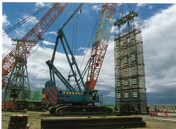
③ 鉄筋籠の建込み状況
