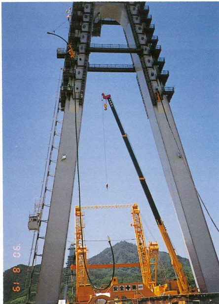
生口橋2P側（因島）側径間のケーブル架設（2年8月）
