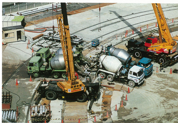
④ コンクリート打設状況
