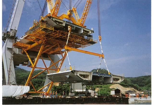
生口橋3P側（生口島）鋼桁架設（2年8月）
