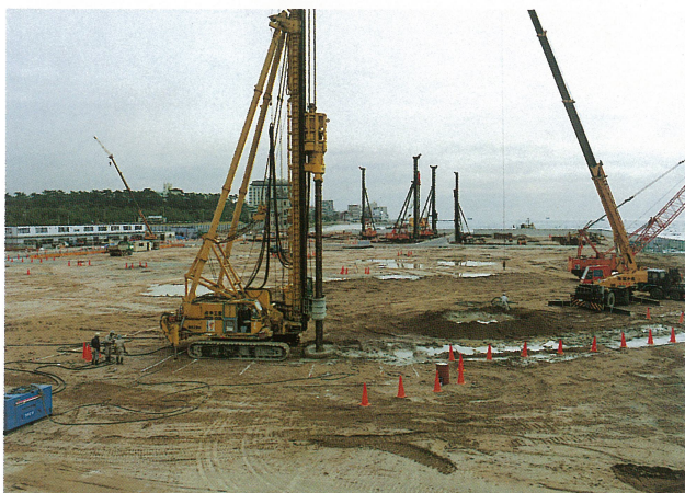
① ソイル・モルタル・ウォール（地盤改良工）施工状況
