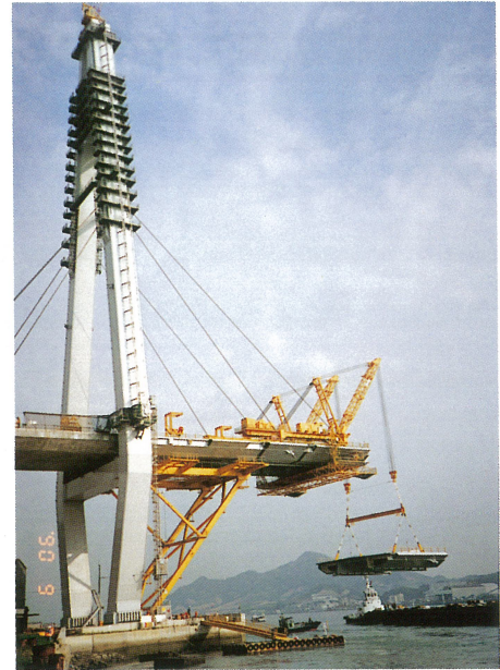
生口橋3P側（生口島）鋼桁架設（2年9月）
