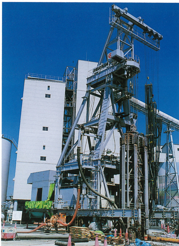
② 水平多軸回転カッター掘削機によるエレメントの掘削状況
