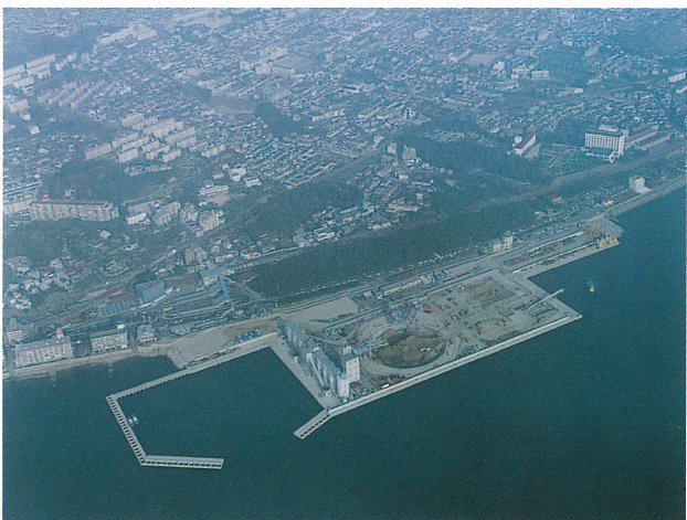
明石海峡大橋1A空撮
