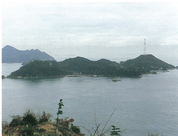
来島大橋馬島北棧橋設置工
