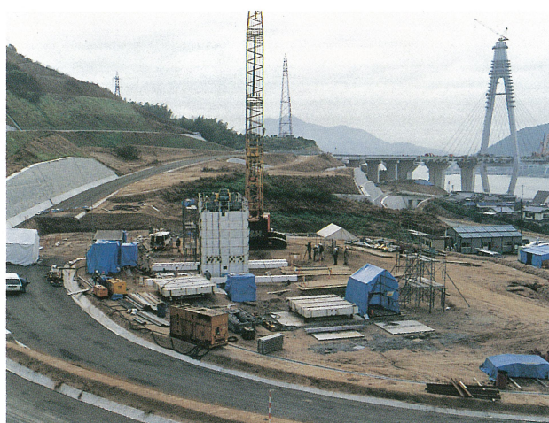
大規模岩盤載荷試験 (生口橋因島側取付部)
