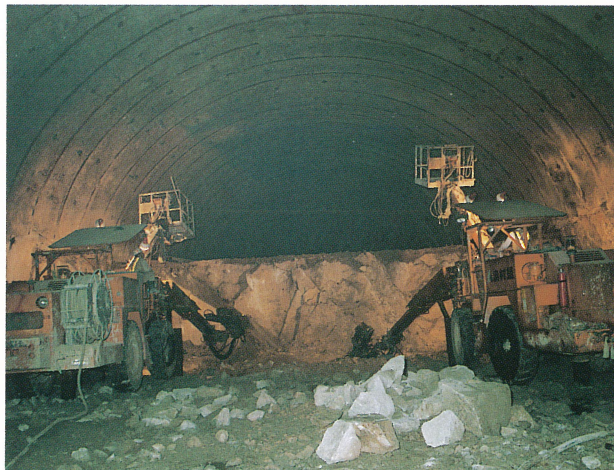
舞子トンネル本坑掘削状況
