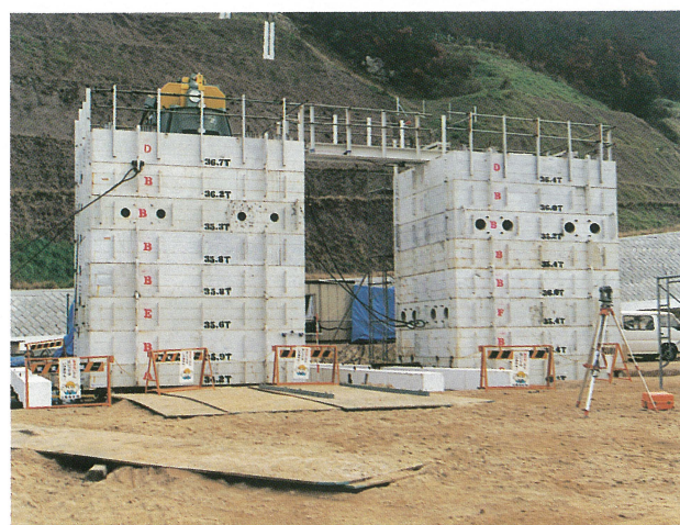
同左振動試験 (左: 試験ブロック、右: 反力ブロック)
