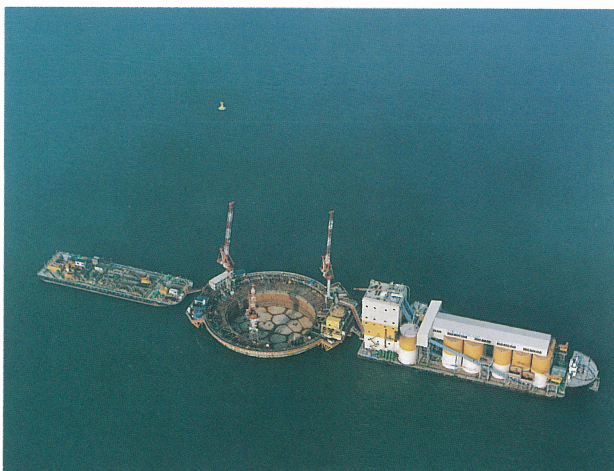
明石海峡大橋2P空撮
