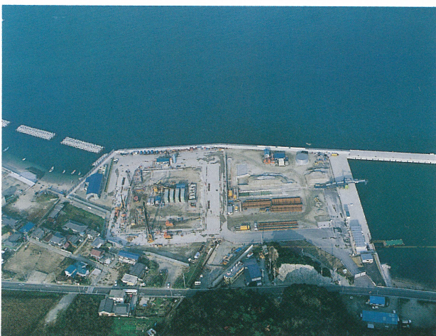
明石海峡大橋4A空撮
