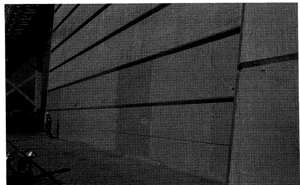
写真-2 BB7A (西側前方側面) 試験塗装状況
