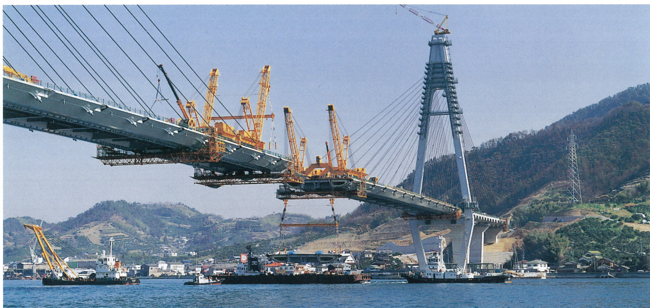
生口橋中央径間桁架設工事 (遠景)
