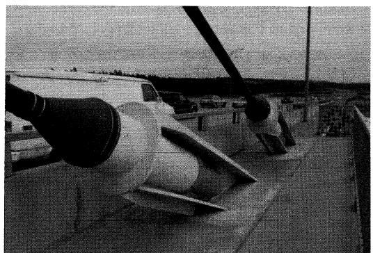
写真-20 アレックスフレーザー橋 定着部構造写真
