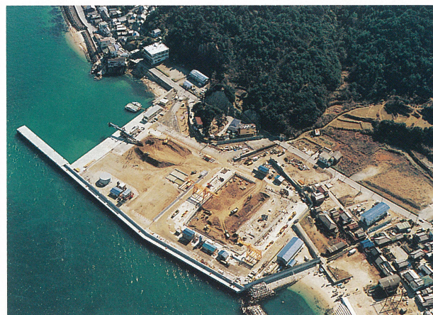
明石海峡大橋 4A 空撮
