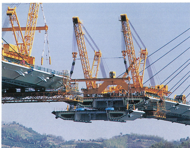
生口橋中央径間桁架設工事 (近景)
