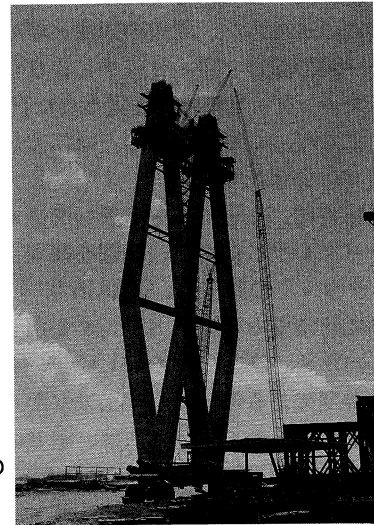
写真-6 ヒューストン・シップの塔工事
