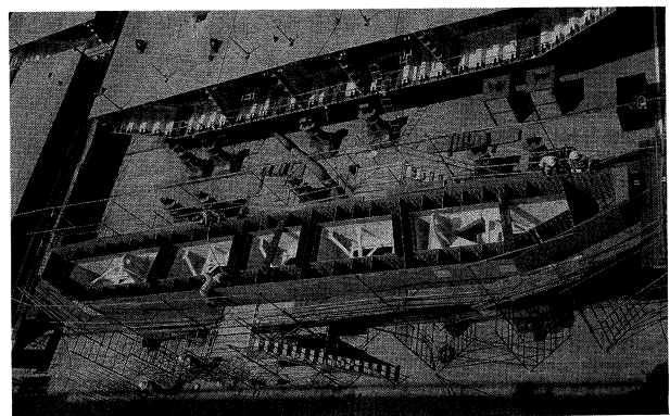
写真-1 接合桁概観
