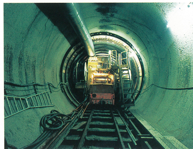
舞子トンネルボーリングマシン作業状況 (1本目到達)
