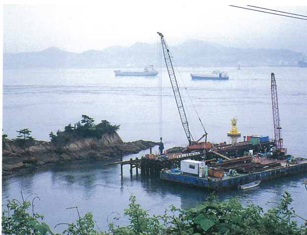
来島大橋8P作業足場（杭打状況）
