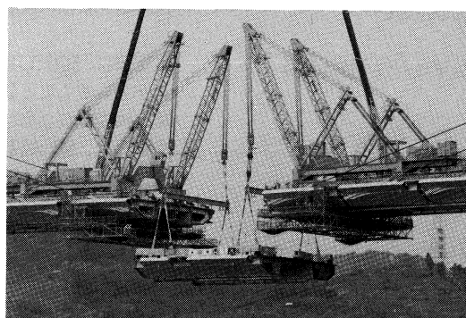
生口橋閉合ブロック吊上げ状況
