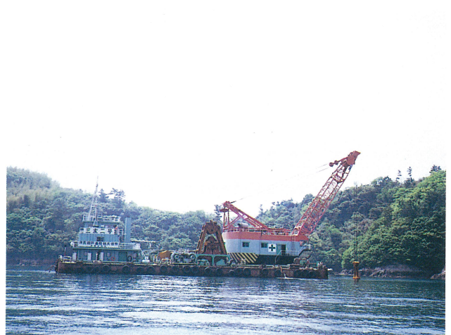
来島大橋4A海底掘削工（砕岩状況）
