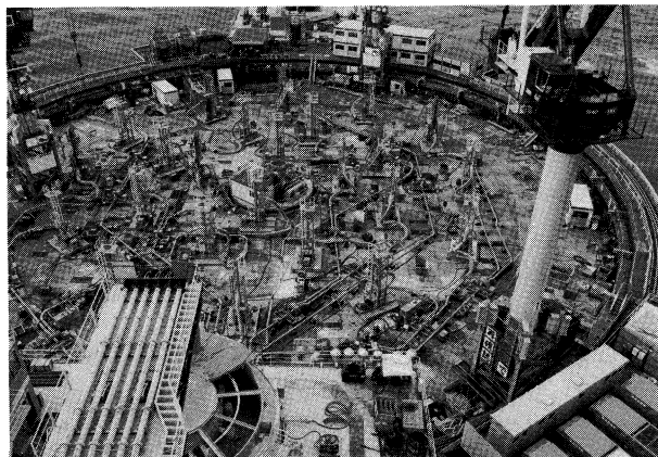
写真-4 内核部の打設状況
