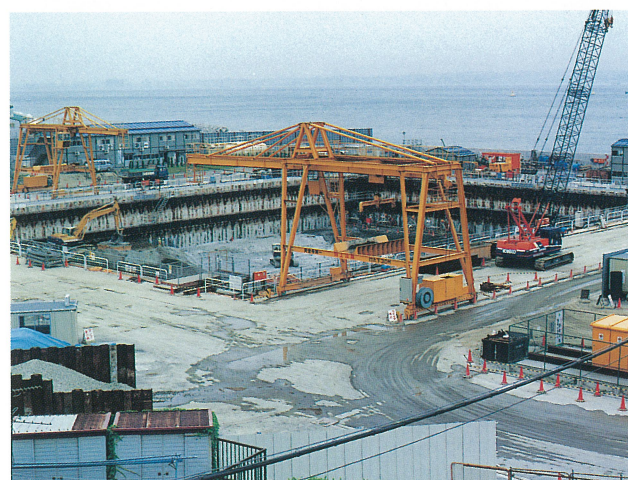
明石海峡大橋4A 全景作業状況
