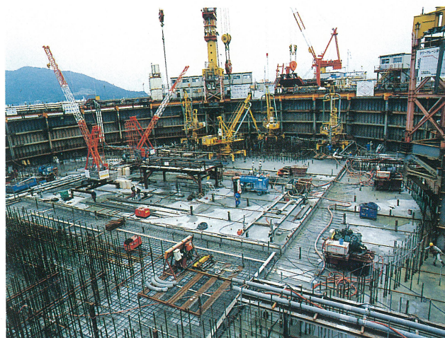
明石海峡大橋3P 気中コンクリート打設状況
