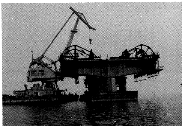
写真-5 銭塘江第二大橋の工事
