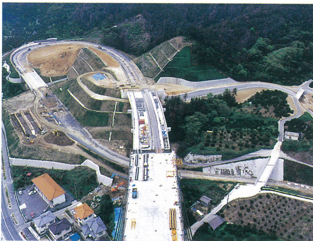
州江側陸上部現況（生口橋3P塔頂より）
